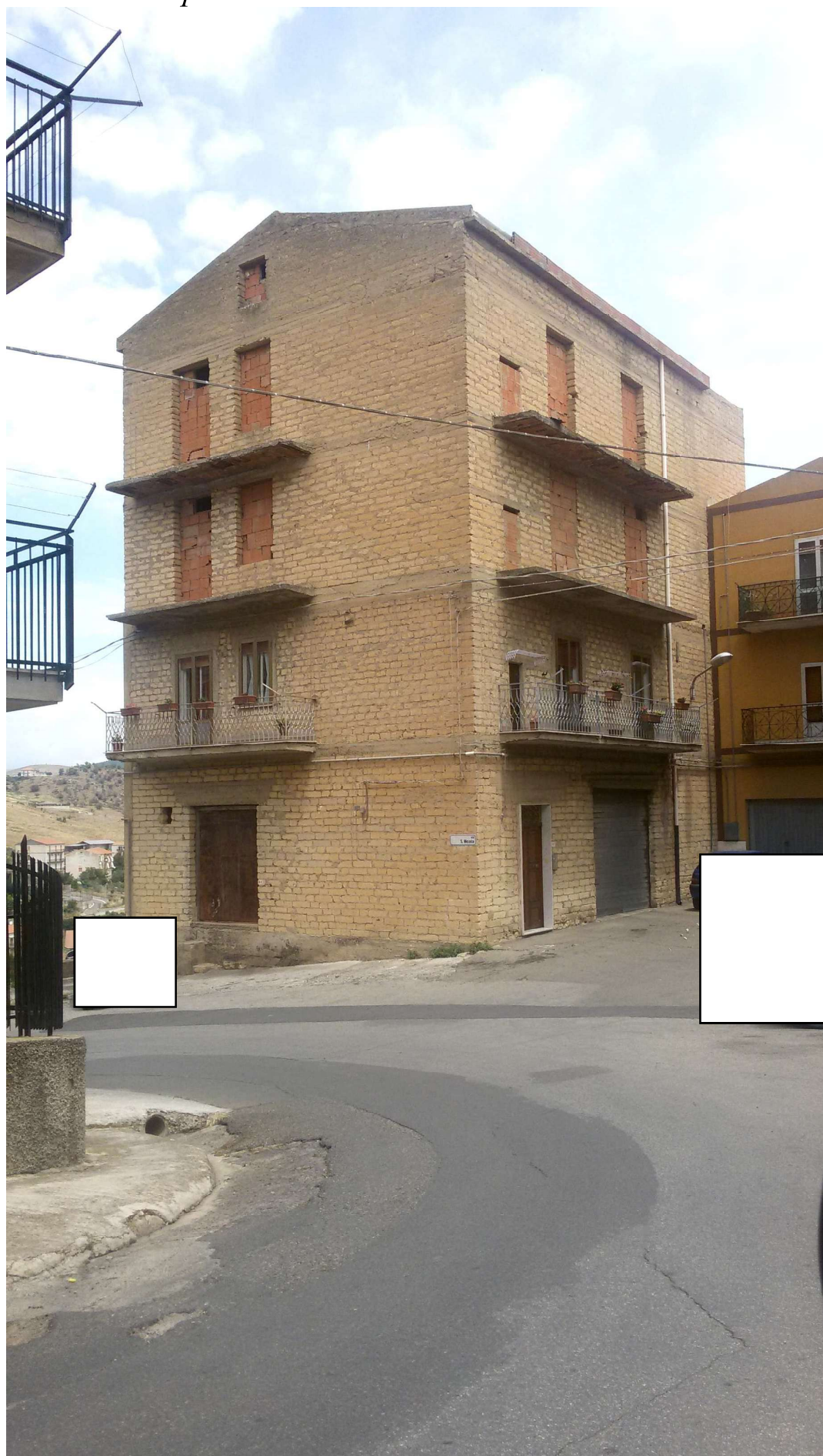
Foto 3 – Vista dell'intero immobile da via S. Nicola Prospetti sud-ovest e sud-est
