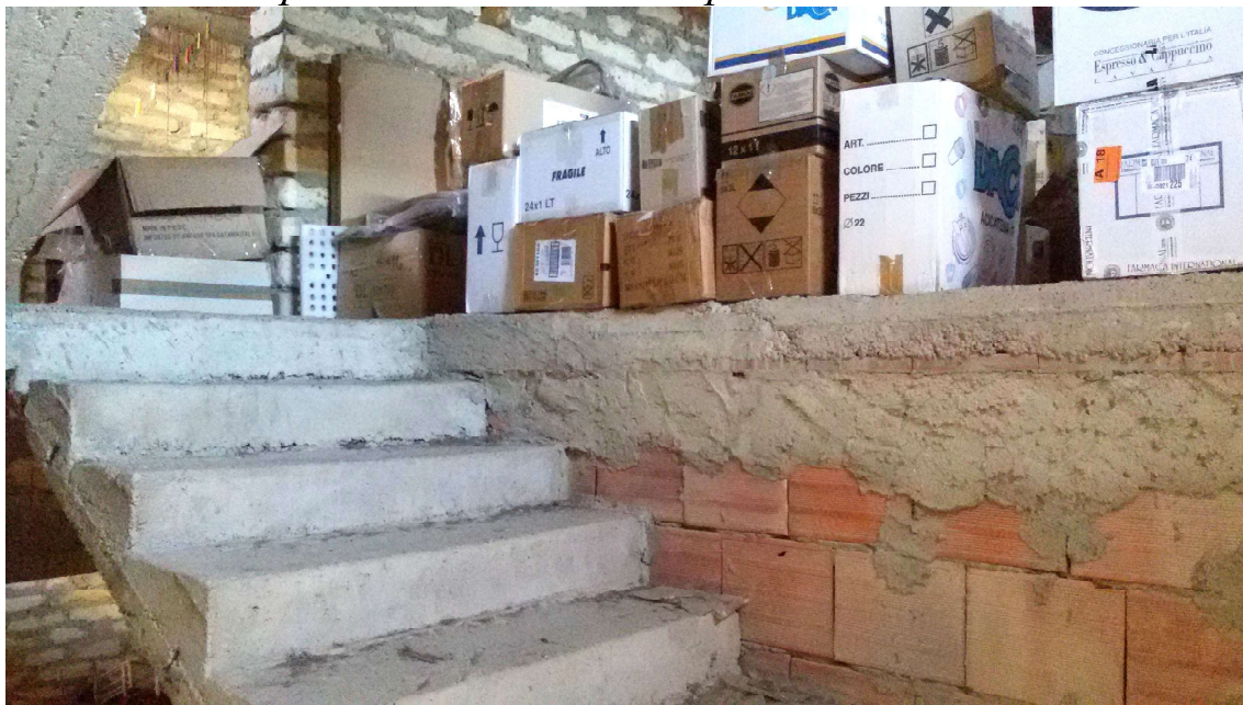
Foto 28 – Rampa scala con arrivo al pianerottolo del P. 3°
