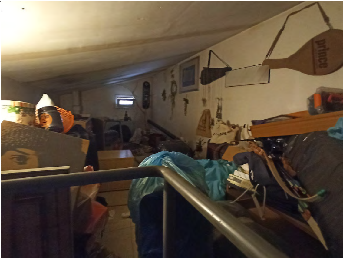
Foto 31 : interno - il sottotetto accessibile per mezzo di botola con scala retrattile
