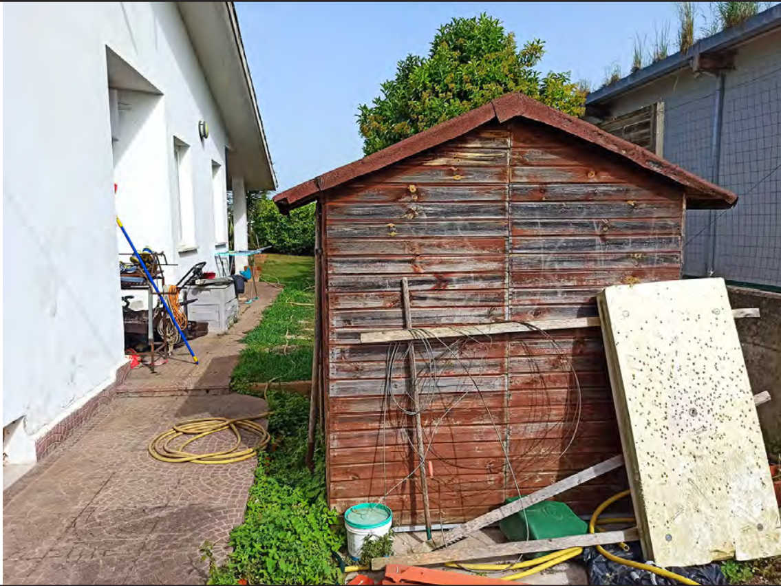
Foto 7 : esterno - vista sul fronte SUD-OVEST con il deposito attrezzi C installato sul cortile e la recinzione in rete e siepe di confine con la part. 63 sub 8
