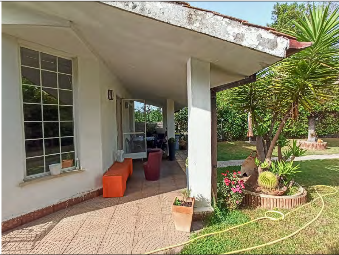
Foto 5 : esterno - il porticato sul fronte d'ingresso SUD - EST
