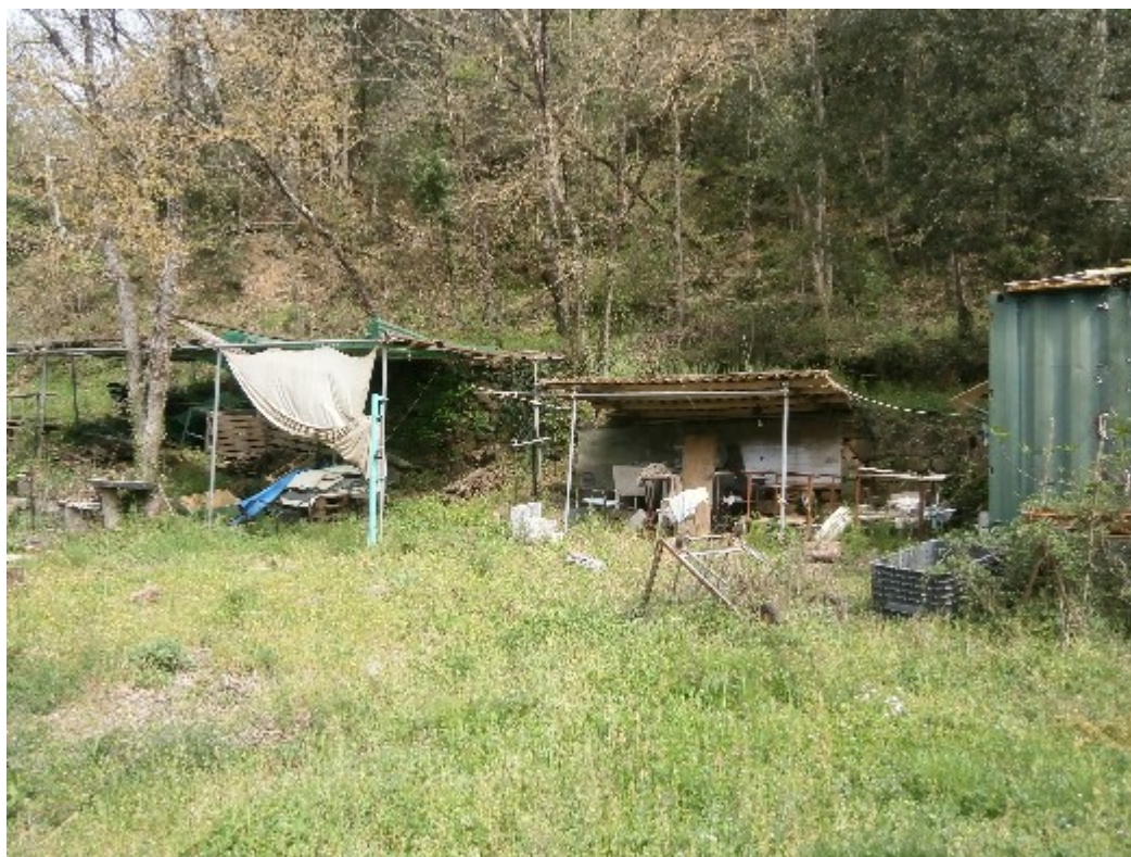
Foto 54: Presenza, nella particella 32 anche di tettoie precarie
