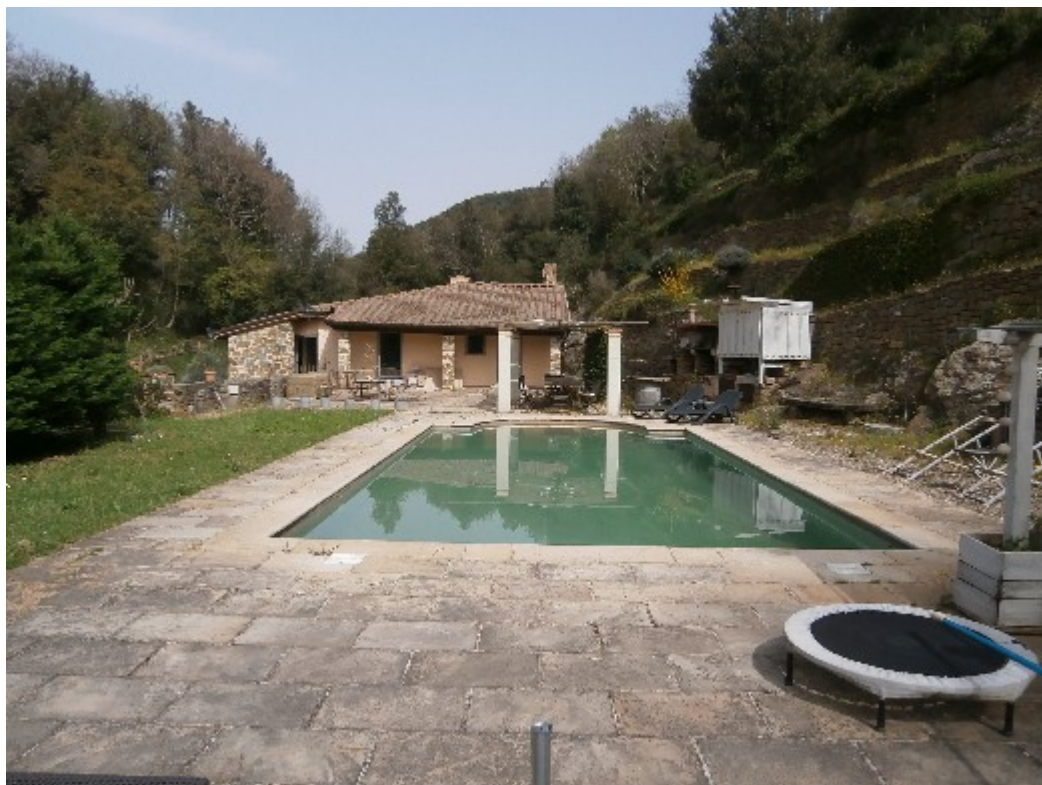
Foto 43: Vista del resede con alle spalle la zona del volume tecnico interrato della piscina. A sinistra vista del barbecue in muratura
