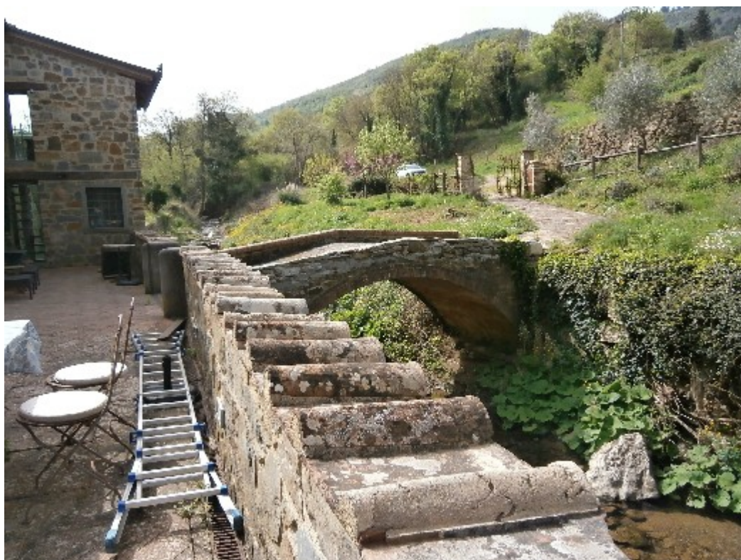
Foto 2: Vista dell'accesso al fabbricato dalla particella 133 e dal ponte sul torrente Sezzatana
