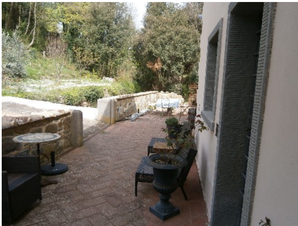
Foto 3: Ingresso al fabbricato dal piano seminterrato
