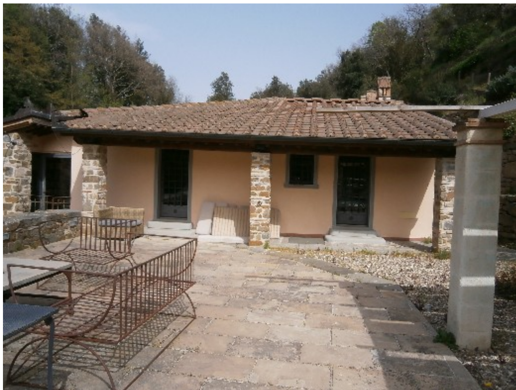
Foto 38: Tettoia con accesso dalla camera 3 – 4 e studio per accedere al resede con piscina
