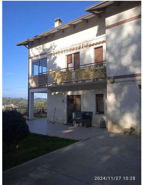
Fotografia A.4 - LOTTO 2 - 1019 VISTA ESTERNA_1732805089584
