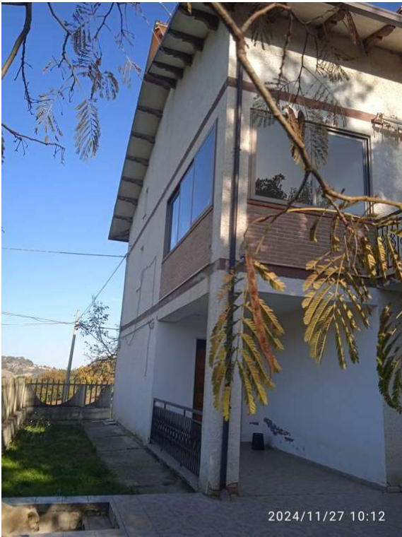
Fotografia A.11 - LOTTO 2 - 1019 sub1 BCNC lato OVEST portico e locali sovrastanti e vano scale_1732805089812
