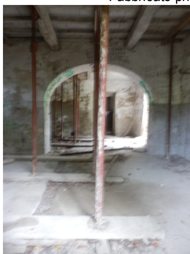
Fabbricato principale - ponteggi e puntellature e vista dall'alto
