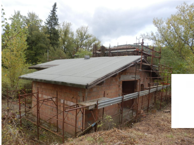
Fabbricato secondario- vista dall'esterno
