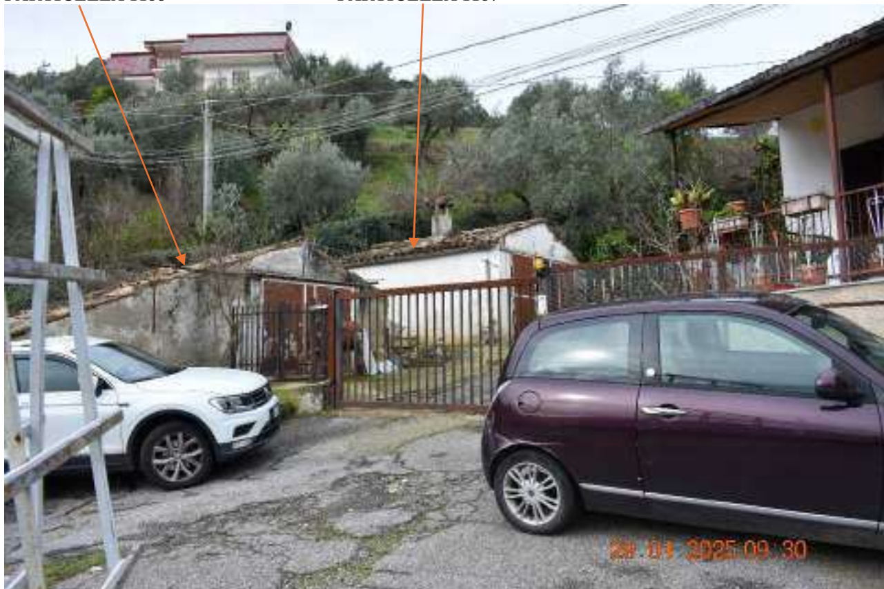
FOTO N.4: - Ingresso principale al fabbricato. Sullo sfondo le tettoie chiuse
