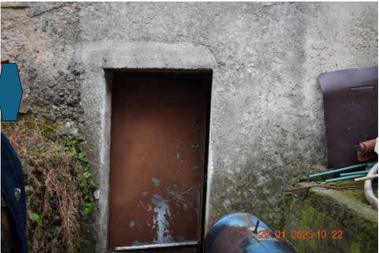
FOTO N.53: Ingresso al vano nel piano interrato dell'appartamento
