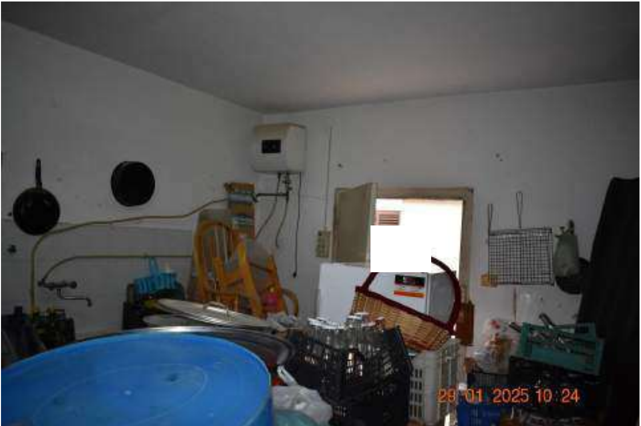
FOTO N.73: Interno locale deposito a piano terra
