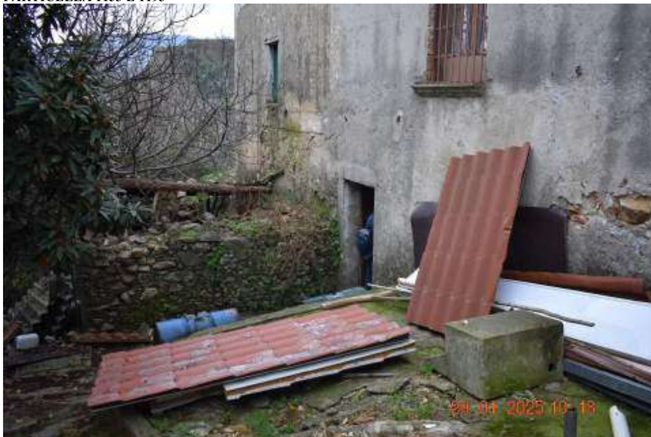
FOTO N.52: Ingresso al vano nel piano interrato dell'appartamento
