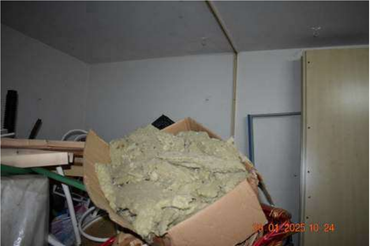
FOTO N.71: Interno locale deposito a piano terra
