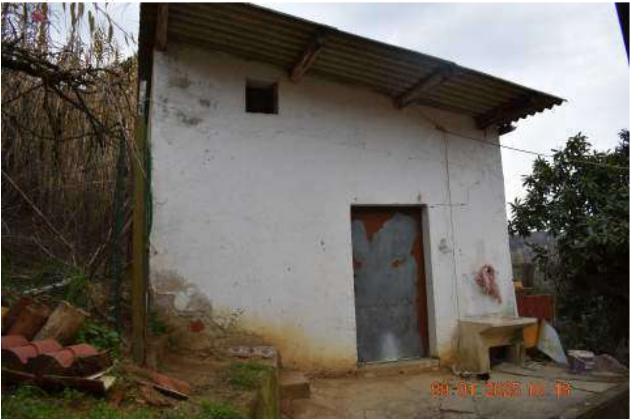
FOTO N.66: Ingresso locale deposito a piano terra
