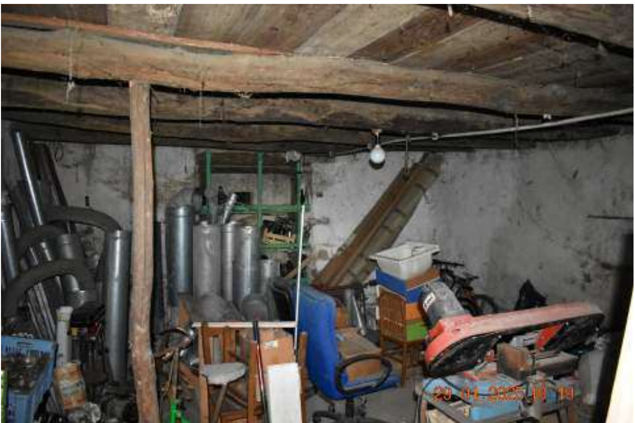
FOTO N.56: Interno del vano del piano interrato dell'appartamento
