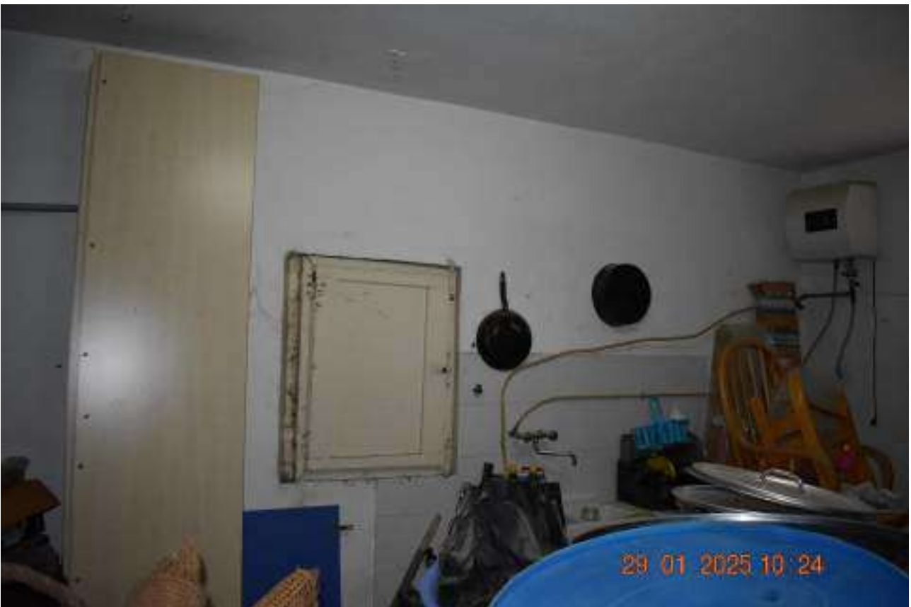
FOTO N.72: Interno locale deposito a piano terra
