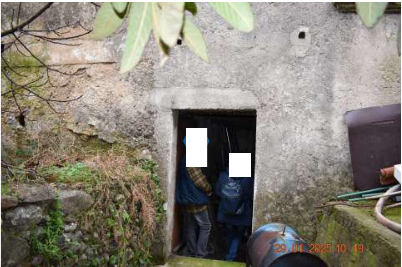
FOTO N.54: Ingresso al vano nel piano interrato dell'appartamento
