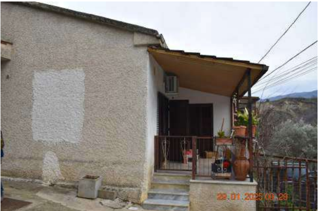
FOTO N.2: Fabbricato Contrada Bernardini - Prospetto Principale. Particolare terrazzo
