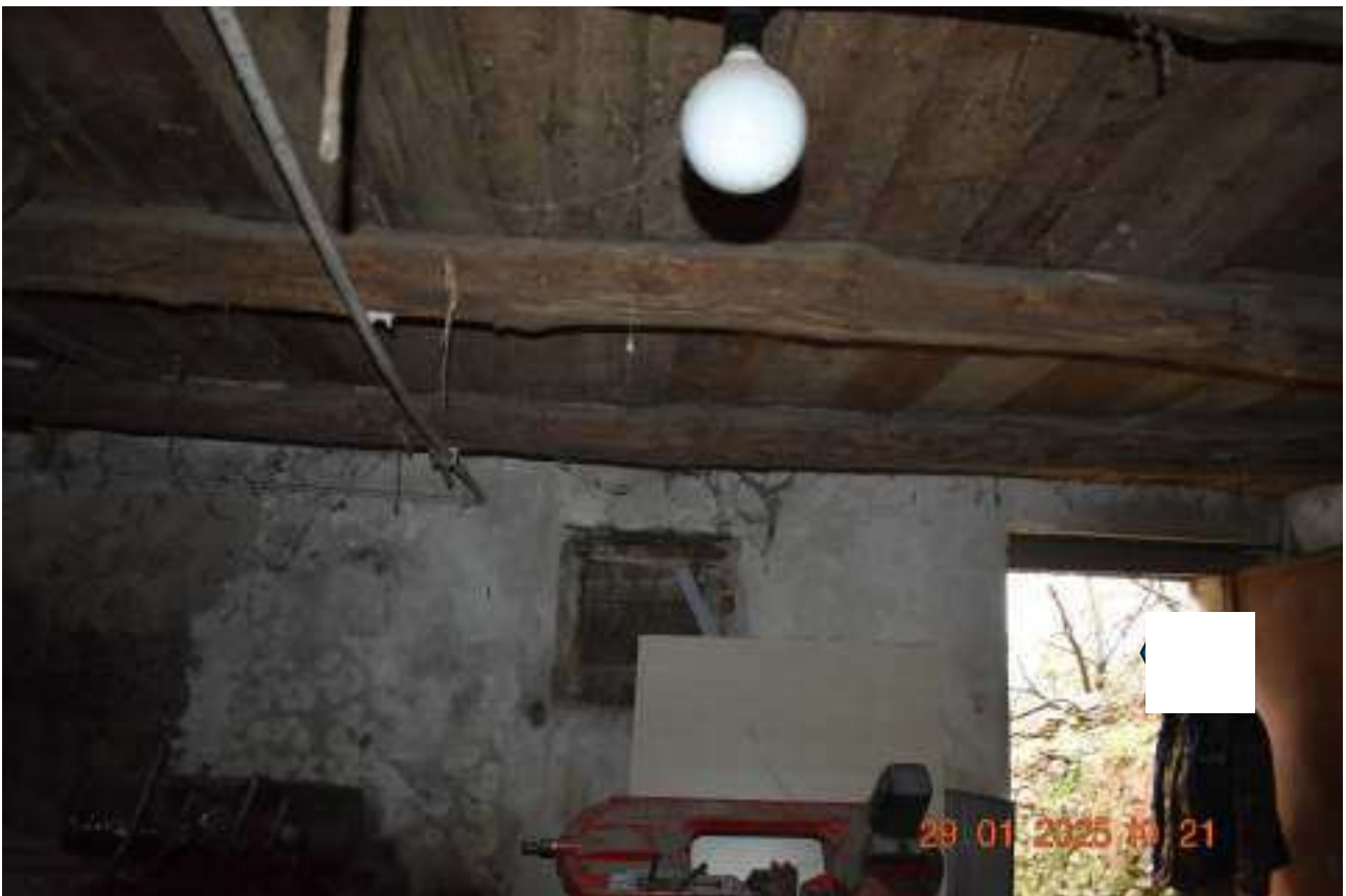
FOTO N.64: Interno del vano del piano interrato dell'appartamento
