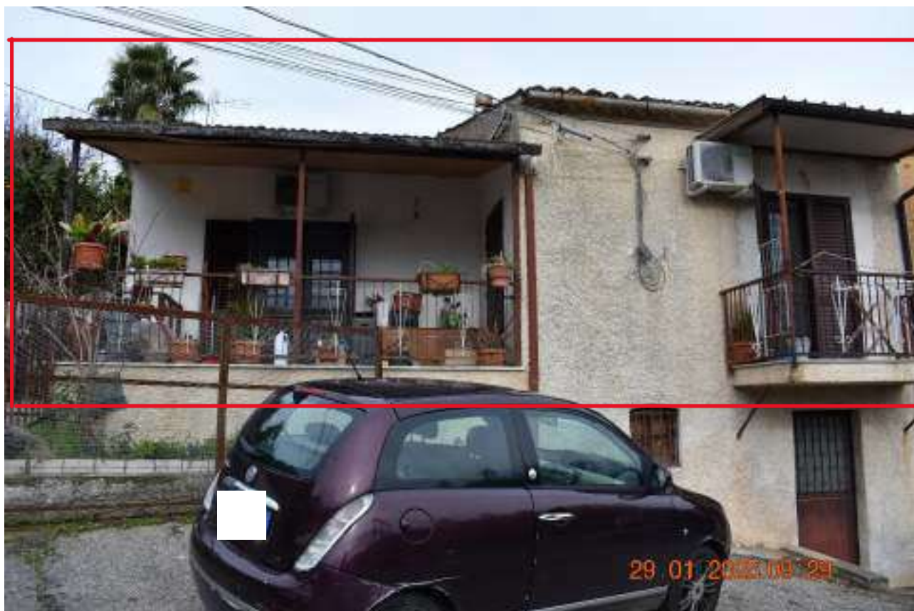
FOTO N.3: Fabbricato Contrada Bernardini - Prospetto Principale. Particolare Terrazzo e balcone. Parte pignorata nel rettangolo rosso
