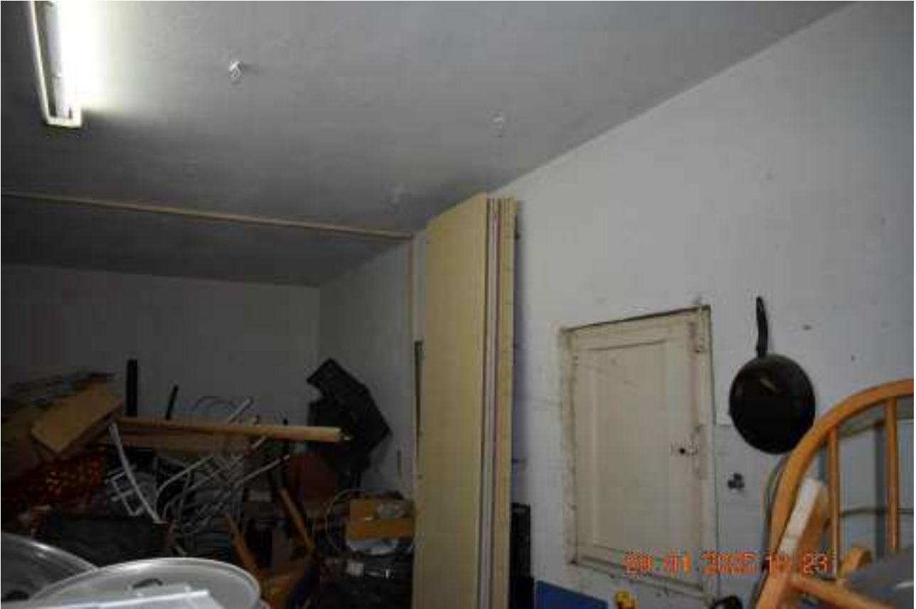
FOTO N.69: Interno locale deposito a piano terra
