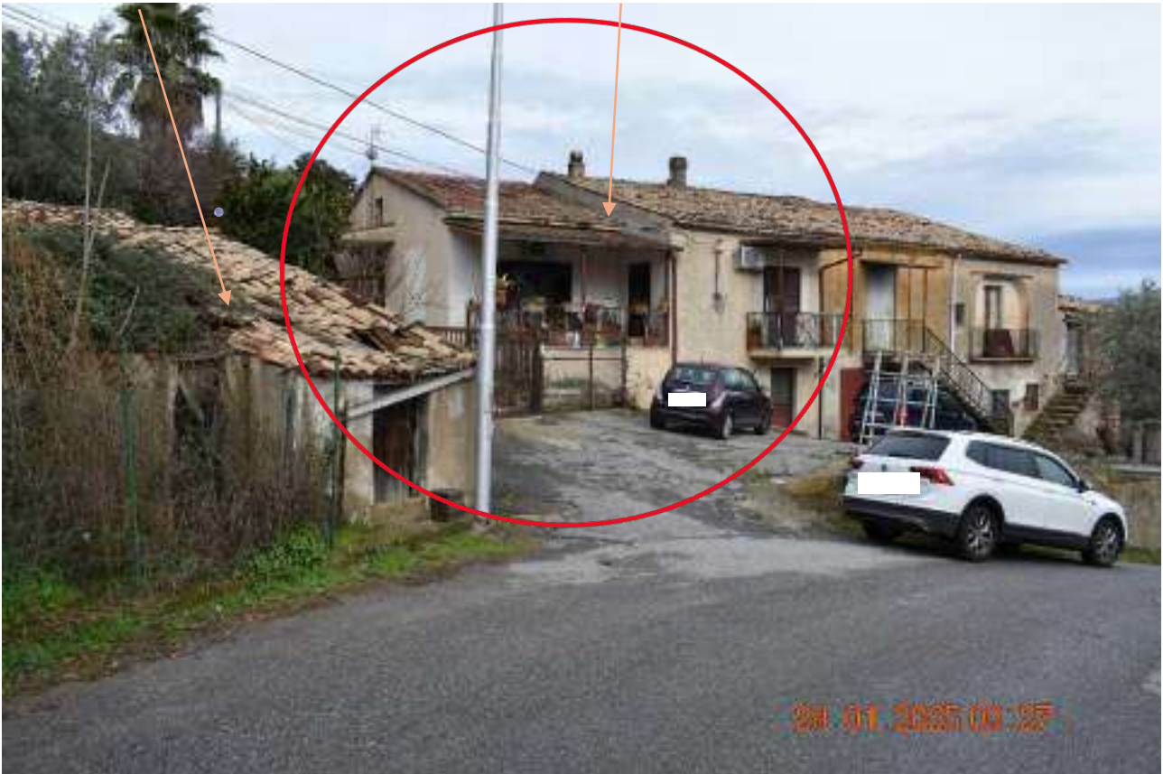
FOTO N.1: Fabbricato Contrada Bernardini - Prospetto Principale – Parte pignorata nel cerchio rosso
