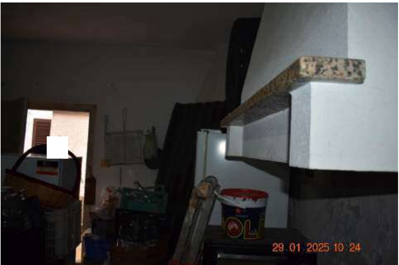
FOTO N.74: Interno locale deposito a piano terra
