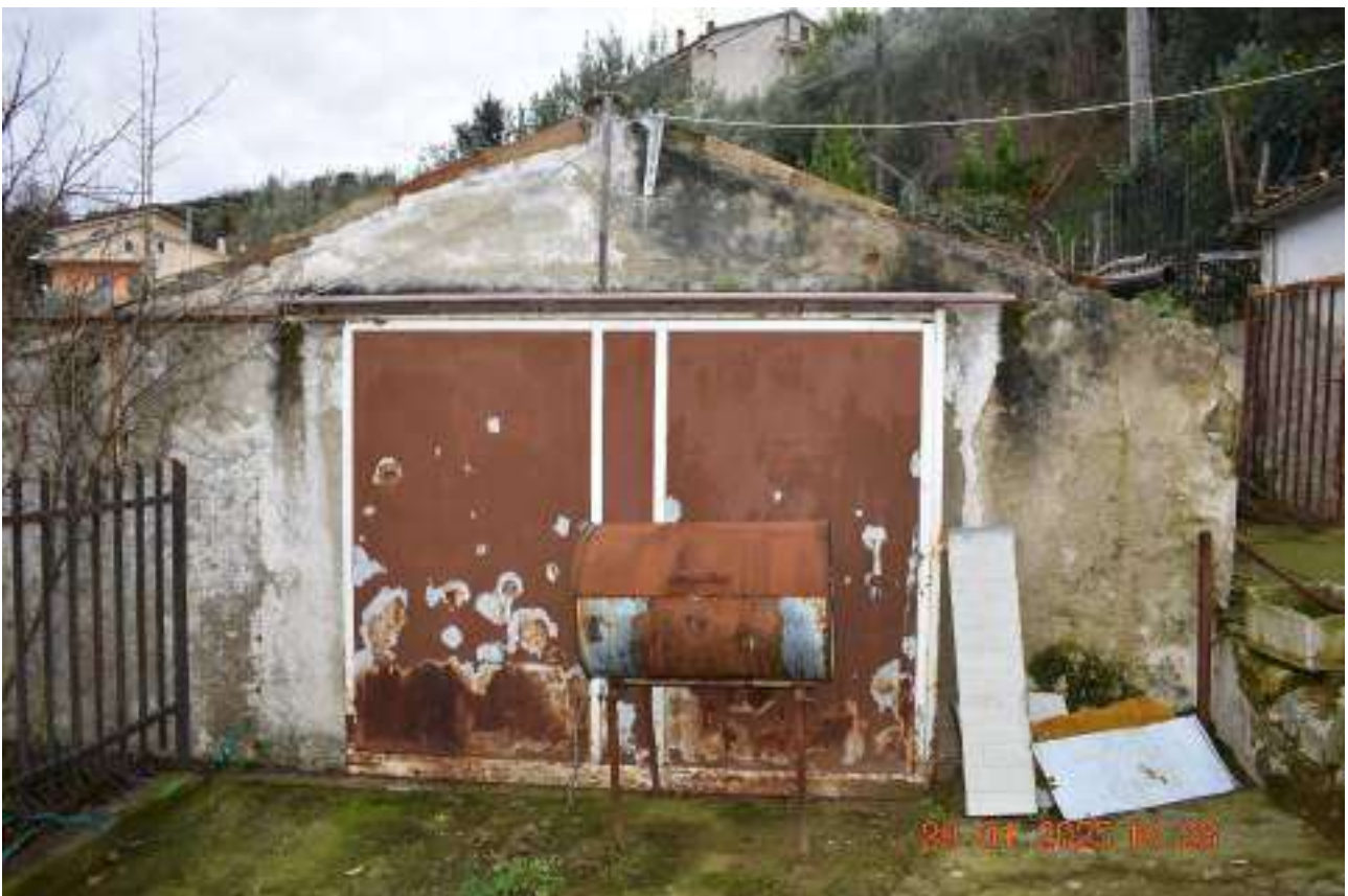
FOTO N.84: La tettoia identificata con la particella 1188.
