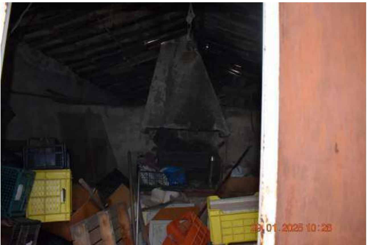
FOTO N.80: La tettoia identificata con la particella 1187. Interno
