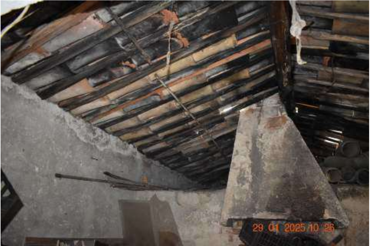
FOTO N.81: La tettoia identificata con la particella 1187. Interno
