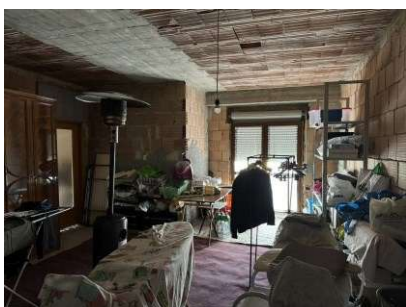
FOTO 40 – Lotto in Corso di Costruzione P. 1.
