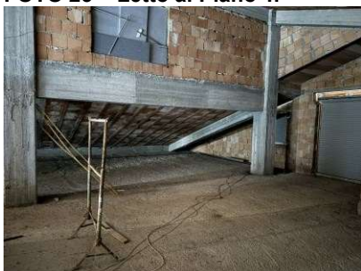
FOTO 28 – Soffitta al Piano Sottotetto.
