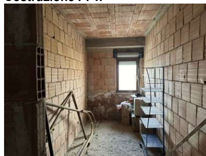
FOTO 45 – Lotto in Corso di Costruzione P. 1.
