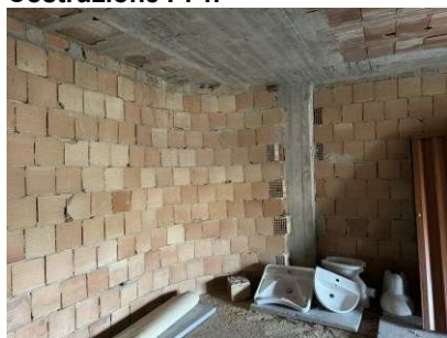
FOTO 44 – Lotto in Corso di Costruzione P. 1.
