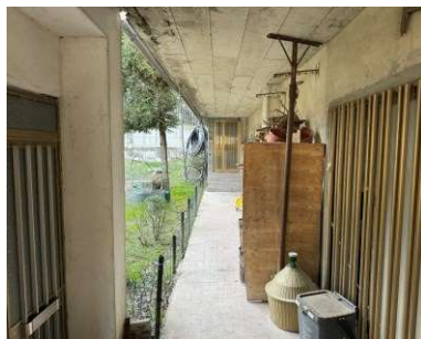
FOTO 8 – Deposito al Piano Ammezzato 2.
