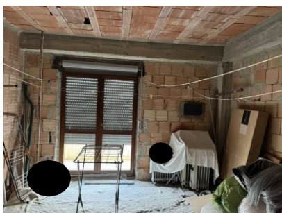
FOTO 41 – Lotto in Corso di Costruzione P. 1.
