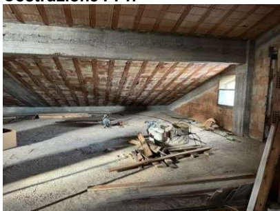
FOTO 46 – Lotto in Corso di Costruzione P. 1.
