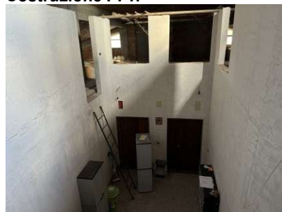
FOTO 48 – Lotto in Corso di Costruzione P. 1.
