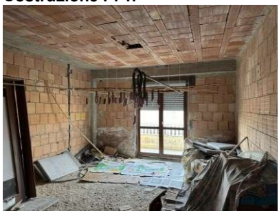
FOTO 43 – Lotto in Corso di Costruzione P. 1.
