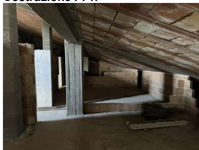
FOTO 47 – Lotto in Corso di Costruzione P. 1.
