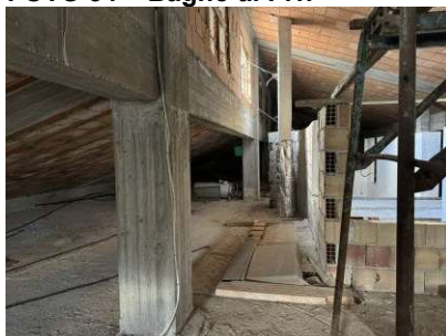
FOTO 57 – Soffitta al P. Sottotetto.
