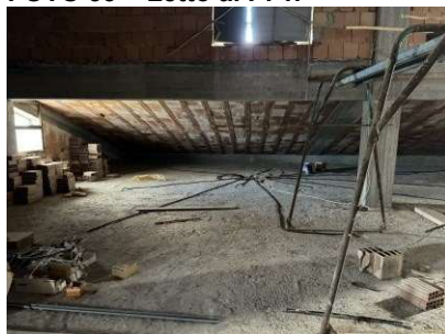
FOTO 56 – Soffitta al P. Sottotetto.
