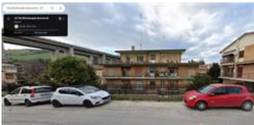
Esterno del fabbricato in Viale Buonarroti n.127 nel Comune di Porto San Giorgio.
