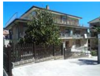
Esterno del fabbricato in Viale Buonarroti n.127 nel Comune di Porto San Giorgio. Particolare accesso carrabile,
