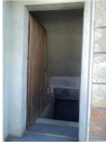
Ingresso esterno dal piano sotto strada alle cantine di pertinenza del piano interrato.
