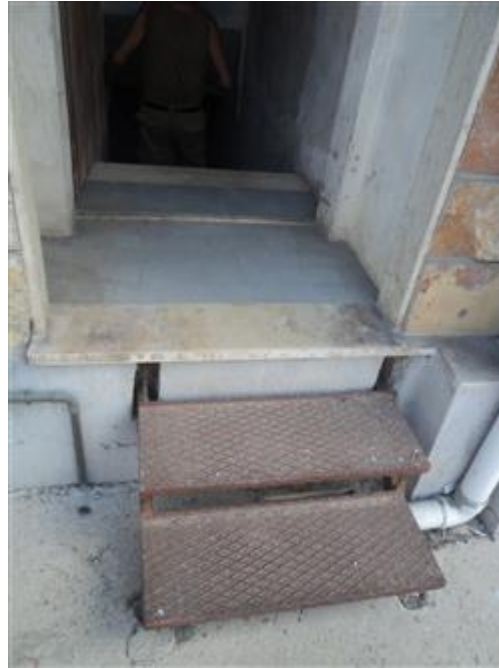
Accesso condominiale secondario posto lungo il prospetto Nord che serve esclusivamente le cantine poste al piano interrato.
