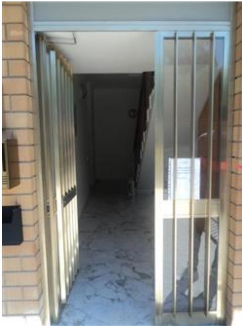
Ingresso condominiale posto al PT.
