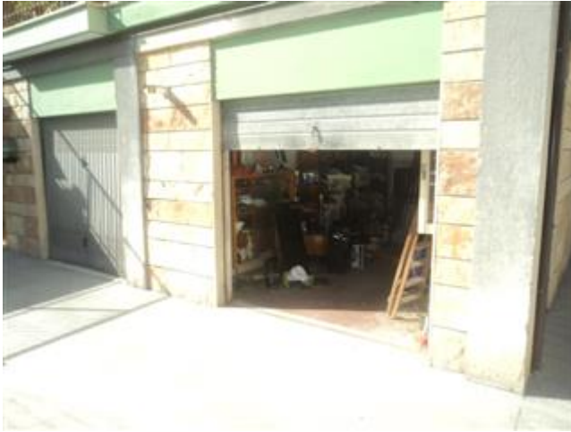
Esterno del garage oggetto di esecuzione posto al piano sotto strada (Sub.8)
