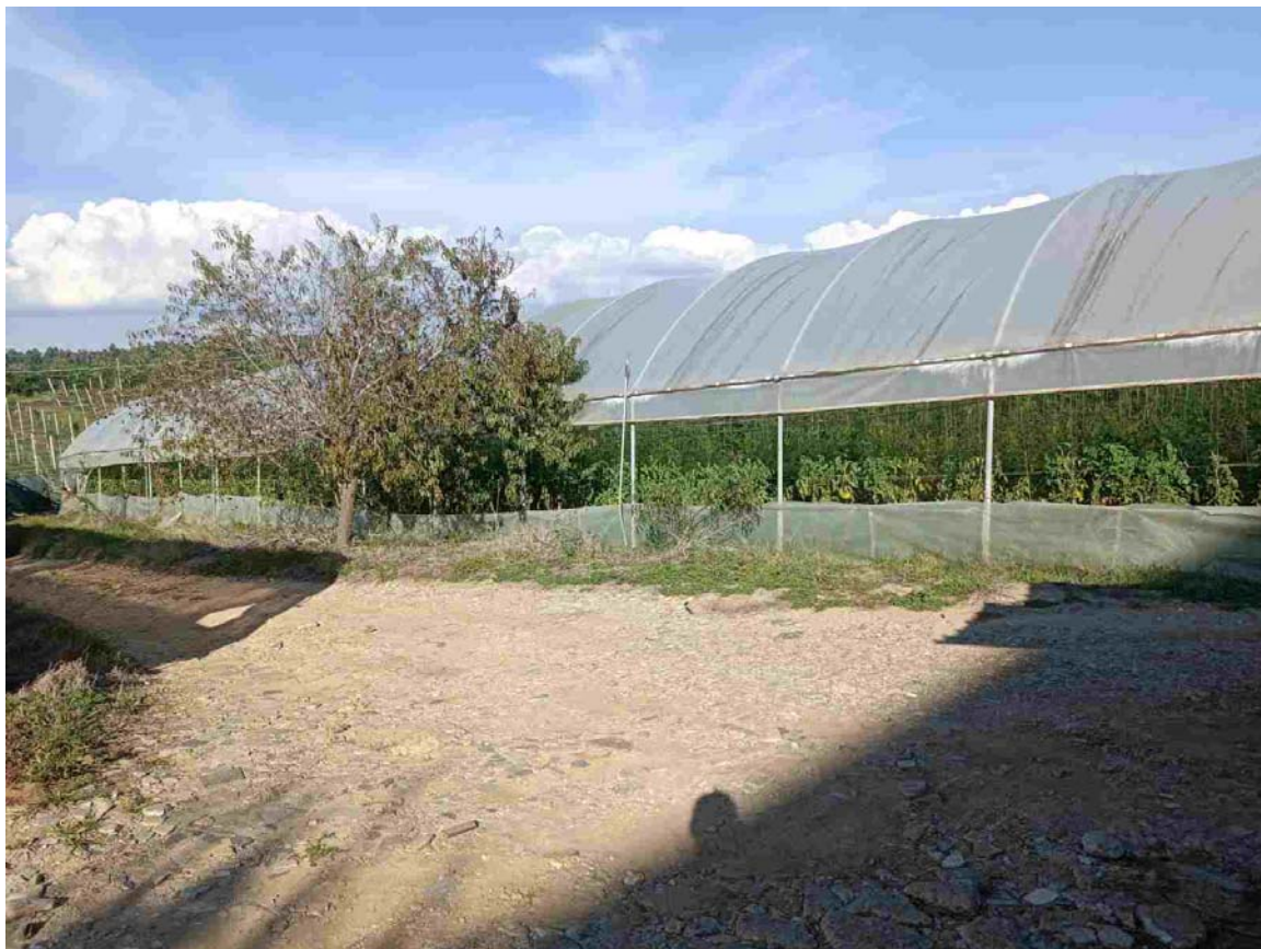
FOTO 5 : Vista del lato lungo delle serre
