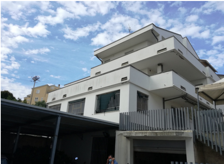
foto 1 Intero fabbricato lato Ovest
