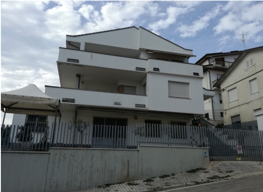
foto 12 Esterno abitazioni al P1 e P2
