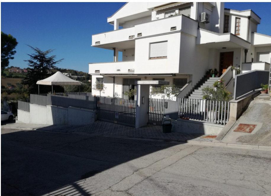
foto 25 Intero fabbricato lato Sud-Est
