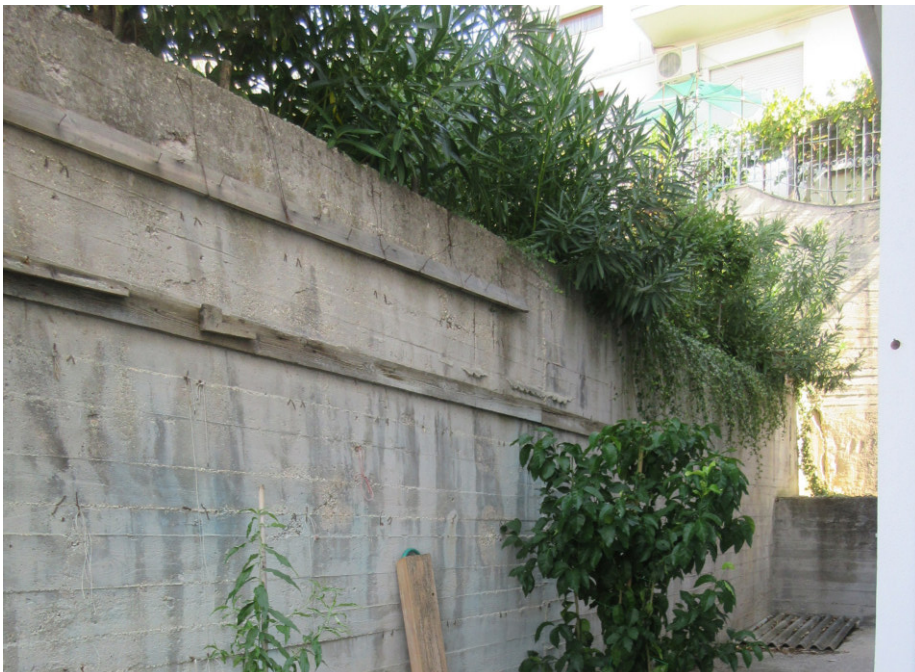
foto 33 Muro di contenimento orto/giard.
