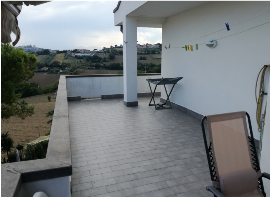
foto 24 Ingresso al PS1 da strada
