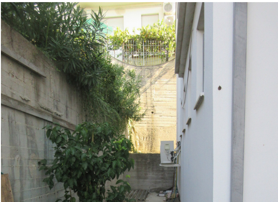
foto 31 Parte retrostante fabbricato a Nord
