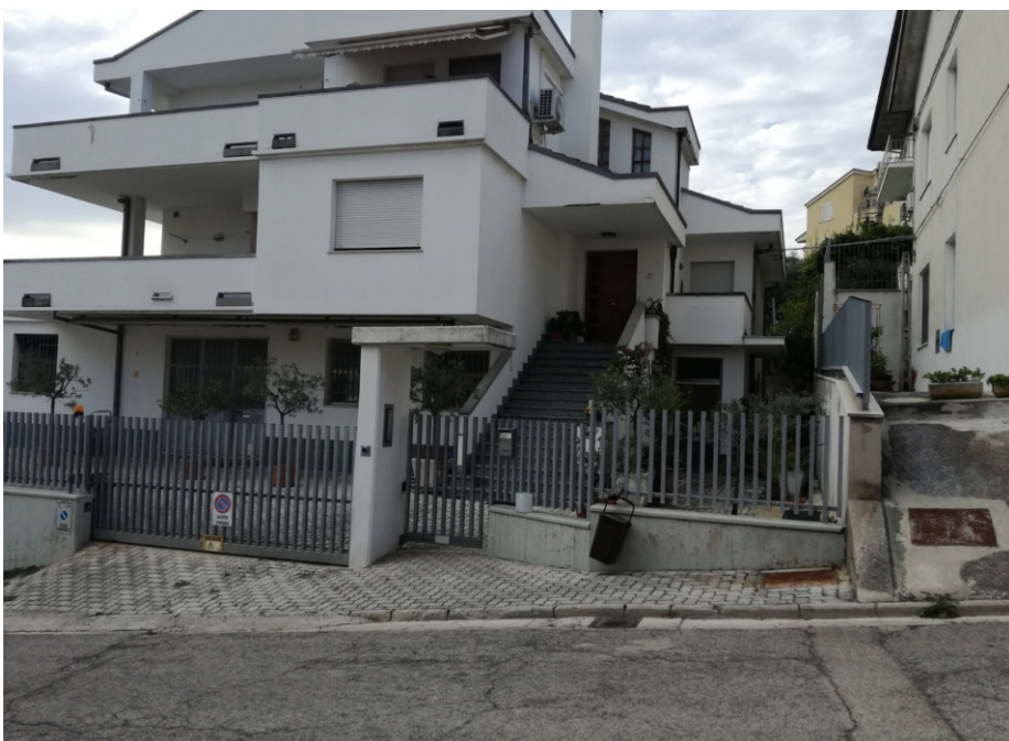
foto 3 Lato Sud, ingressi e scala
