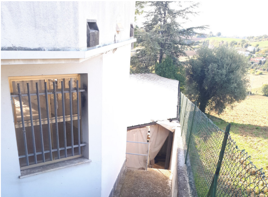
foto 26 Recinzione lato Ovest
