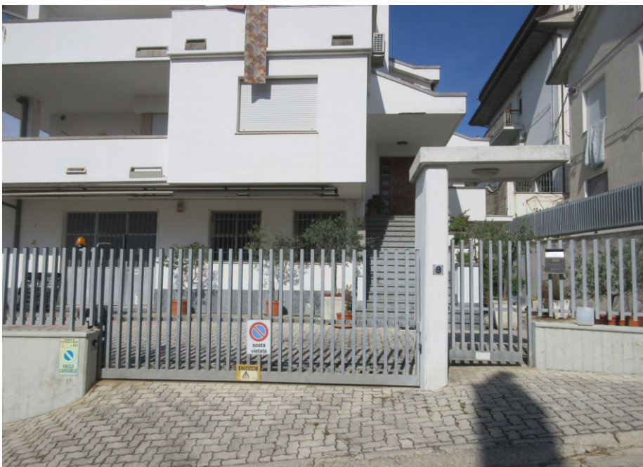
foto 34 Ingressi carrabile e pedonale a Sud
