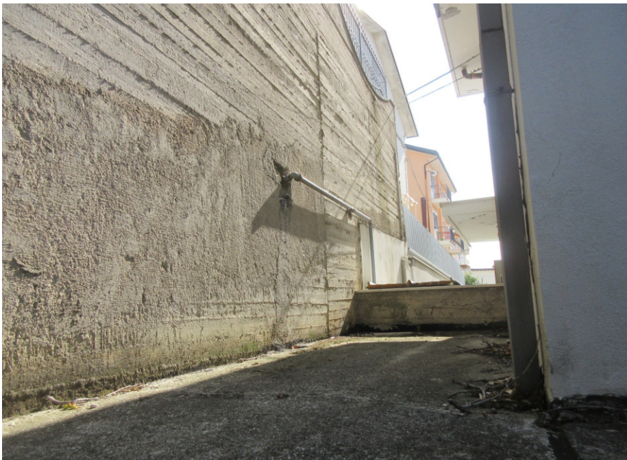
foto 30 Parte esterna superiore cunicolo
