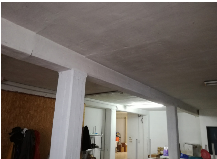
foto 5 Soffitto locale deposito al PS1
