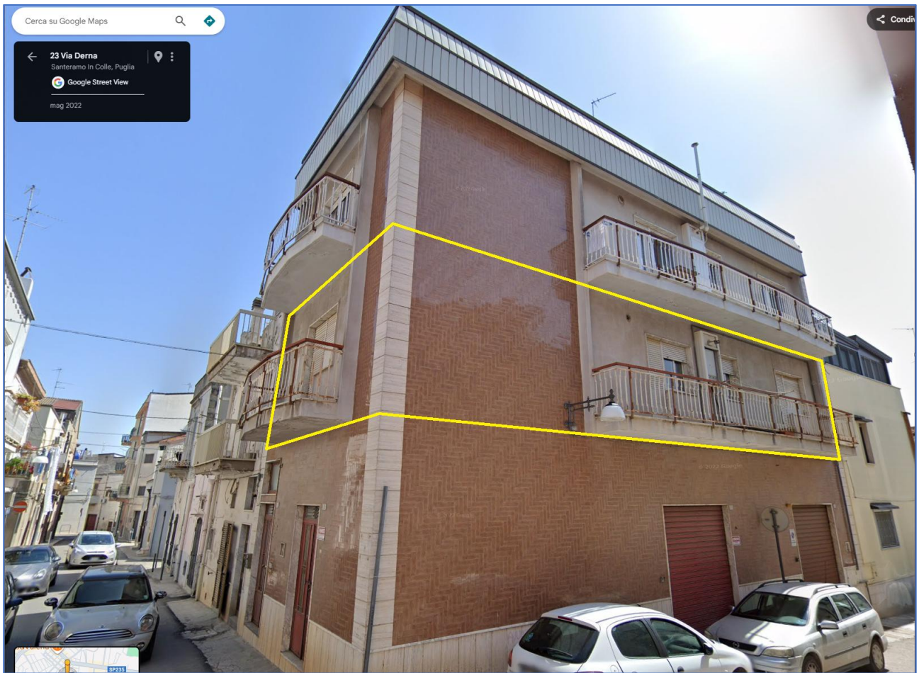
Figura 2: Fotografia dell'immobile oggetto di pignoramento (Fonte Google Maps Street View elaborata)
