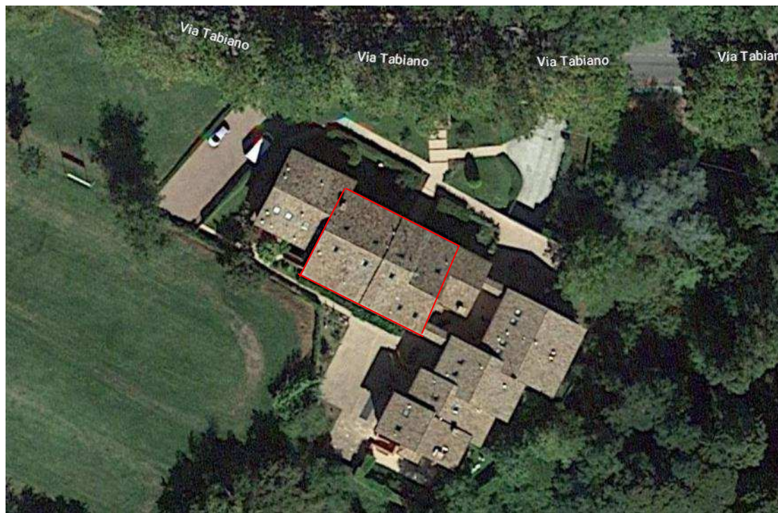
Vista della parte del sottotetto oggetto del lotto 4
