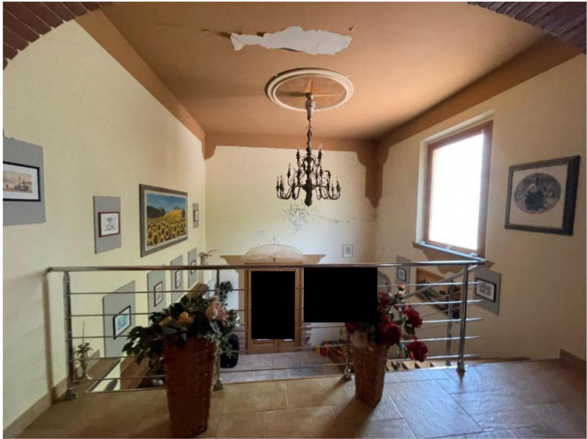
Foto 9 – piano primo - soggiorno
