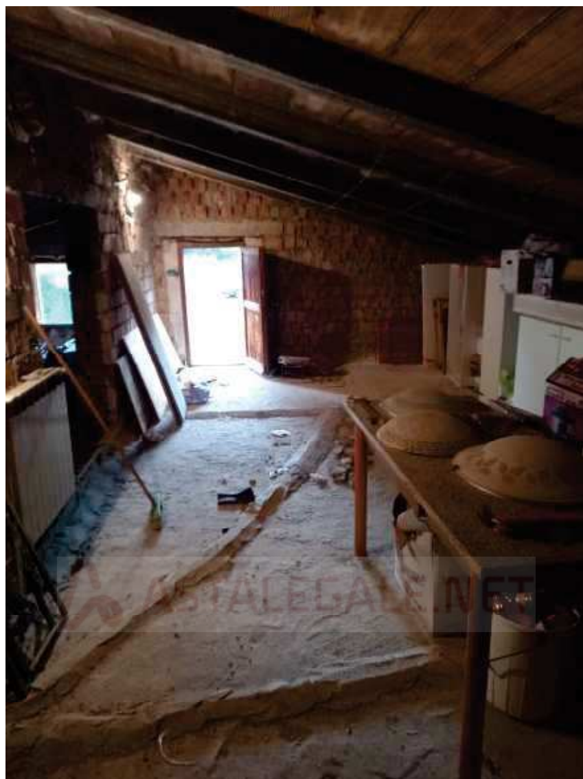
Vista Soffitta Piano Sottotetto
