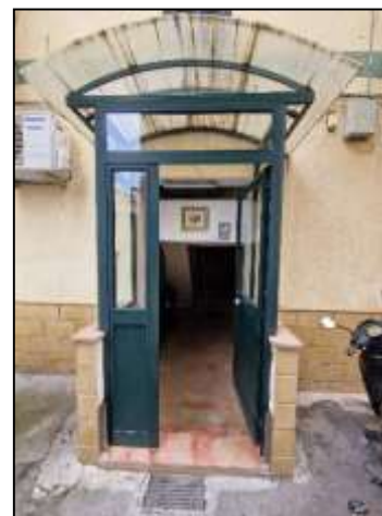
All. 10 – Foto 2 Portone d'ingresso palazzina di Via Kaggera, 46
