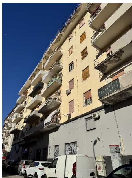
Foto 4 - Prospetto via A. Furitano
