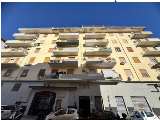
Foto 1 - Prospetto via A. Furitano
