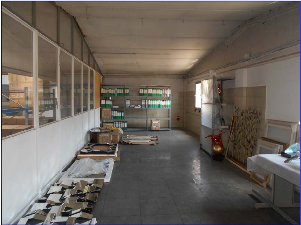
Foto 80: CORPO B - Capannone industriale. Soppalco.
