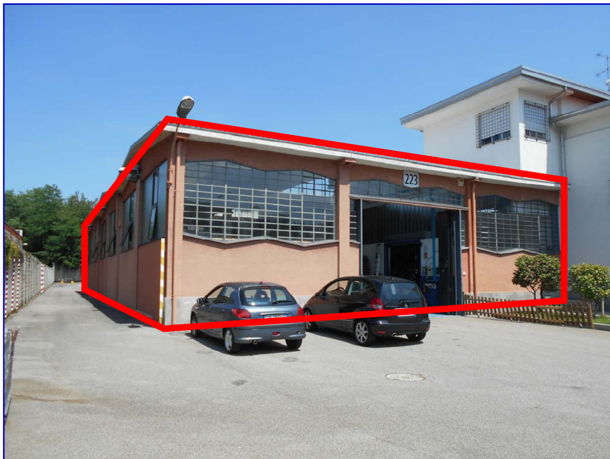
Foto 74: CORPO B - Capannone industriale.
