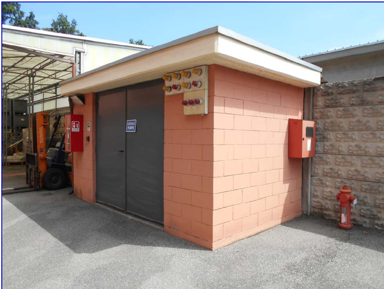
Foto 76: Locale pompe per il quale sono previste opere di regolarizzazione.
