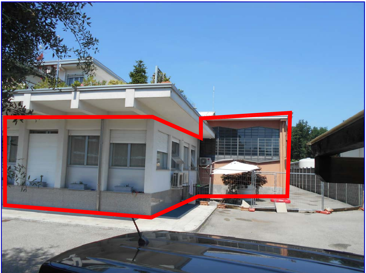
Foto 49: CORPO B - Uffici e capannone industriale.
