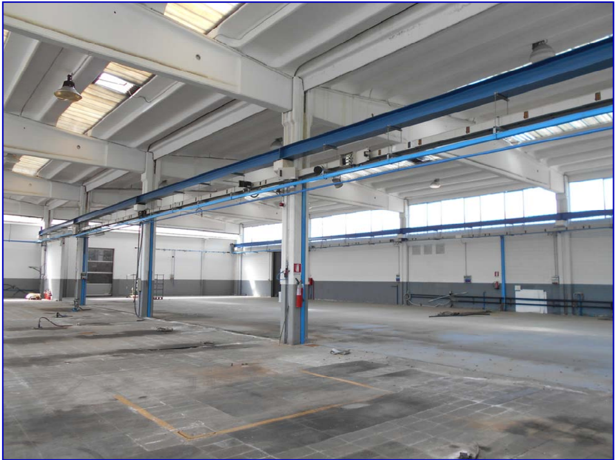
Foto 18: Vista interna del capannone afferente al Lotto 5.
