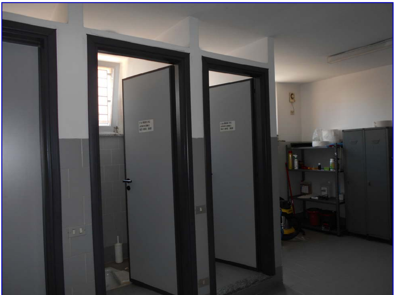
Foto 81: CORPO B - Capannone industriale. Bagni e spogliatoi.
