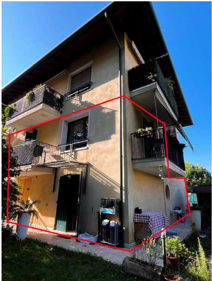
VISTA NORD EST
