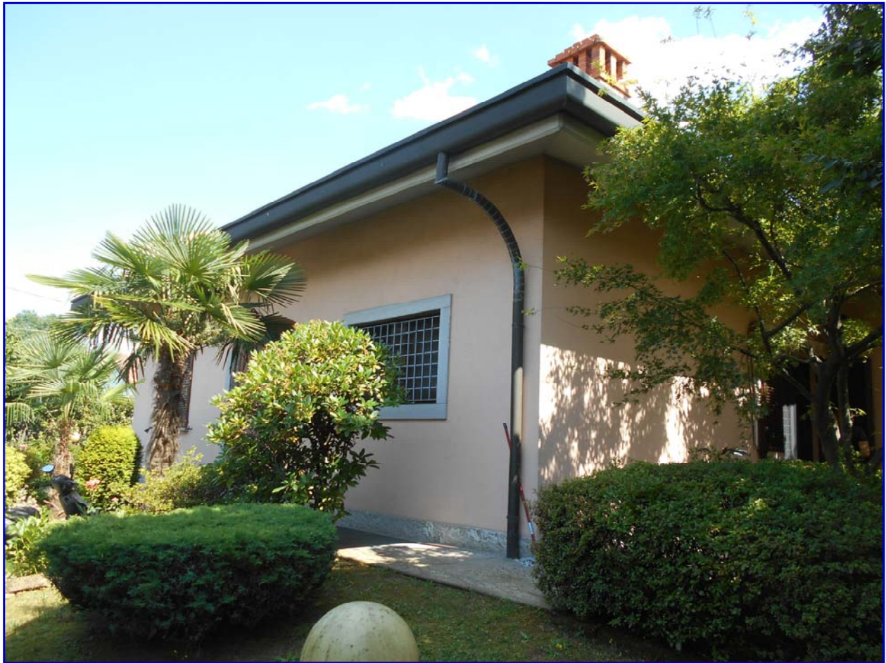
Foto 4: Vista esterna dell'immobile (lato Nord) scattata da giardino pertinenziale.
