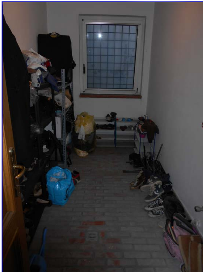
Foto 32: Piano interrato, cantina vini/ripostiglio.
