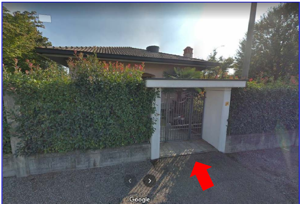
Foto 3: Ingresso pedonale all'abitazione sita in via don G. Nava n. 96 a Gorla Minore (VA). Foto tratta da Google Maps.
