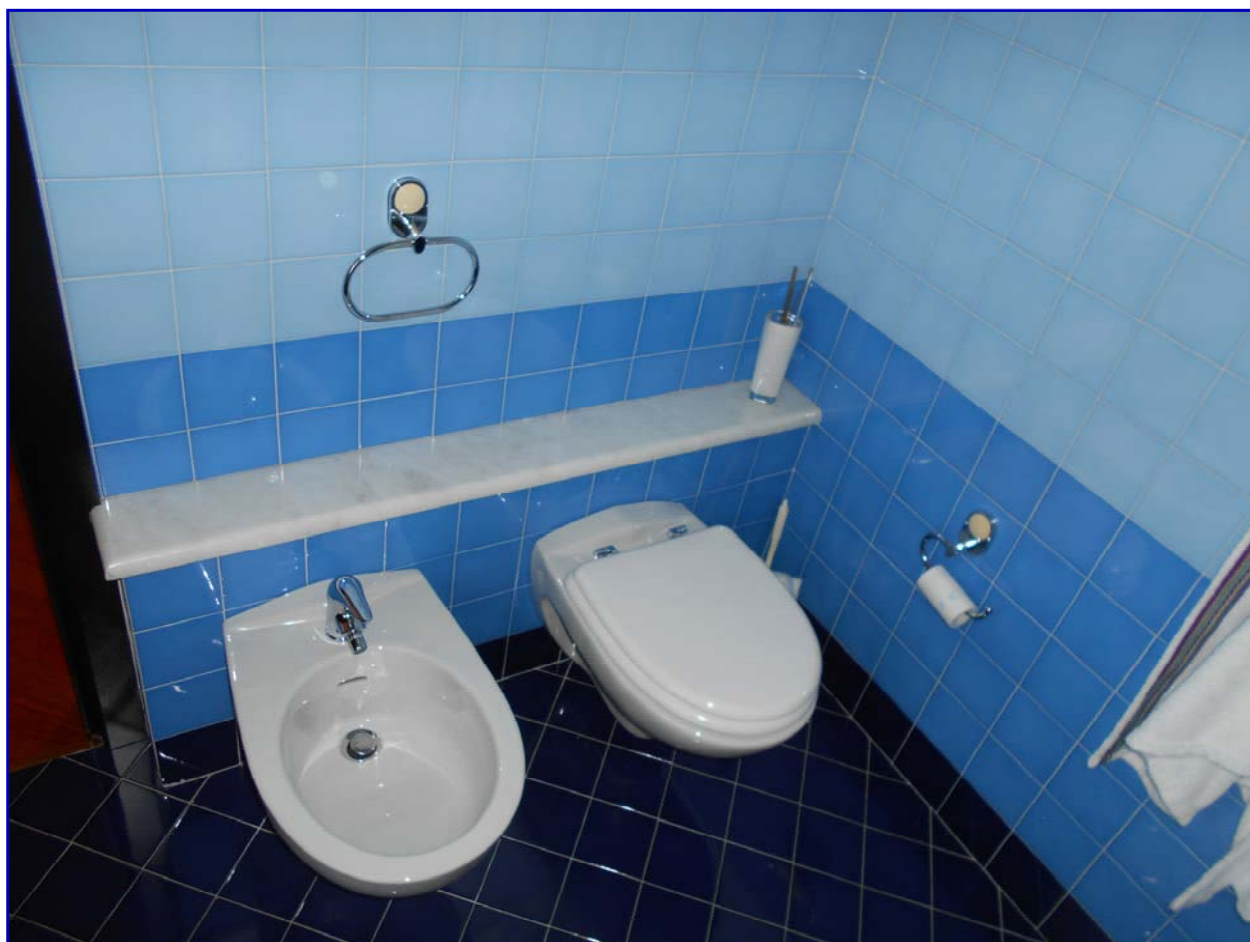
Foto 33: Bagno annesso alla camera singola.
