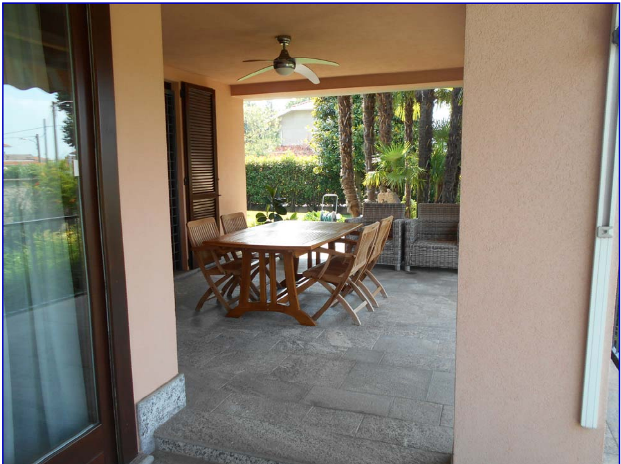
Foto 15: Porticato ubicato lungo il fronte Ovest della villa.
