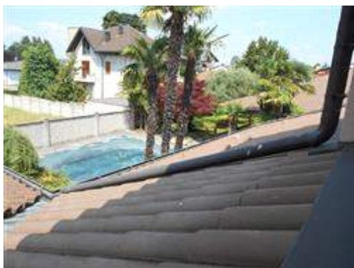
Piscina realizzata su area scoperta comune.
