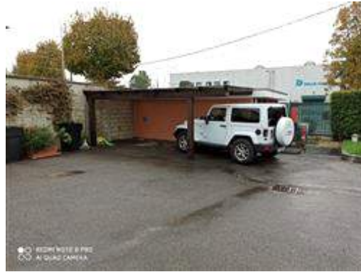
Locale consegna della corrente elettrica con attigua tettoia
