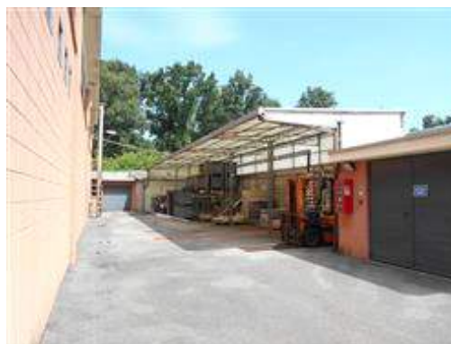
Locale pompe, tettoia a confine e pavimentazione in asfalto.
