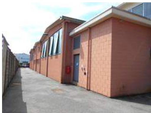
Locale Centrale termica e pavimentazione in asfalto.
