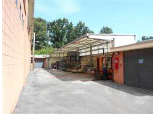
Locale pompe, tettoia a confine e pavimentazione in asfalto.
