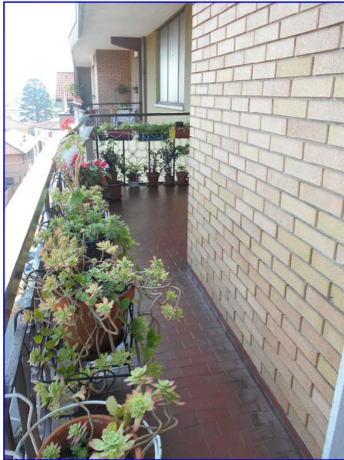
Foto 24: Balcone su fronte Nord (via Italia).
