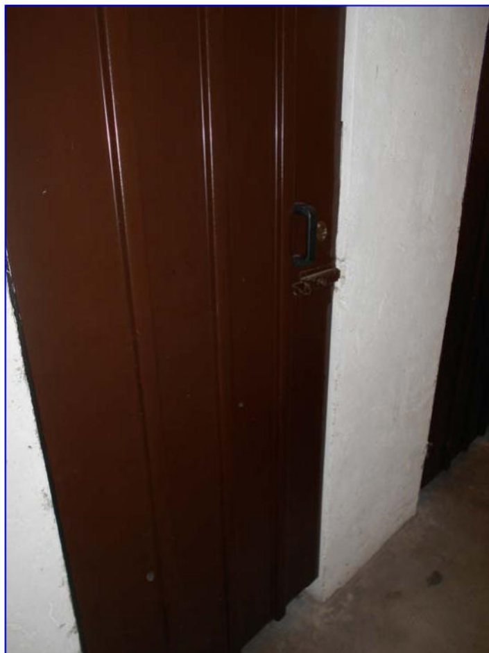
Foto 33: Porta della cantinola di proprietà.
