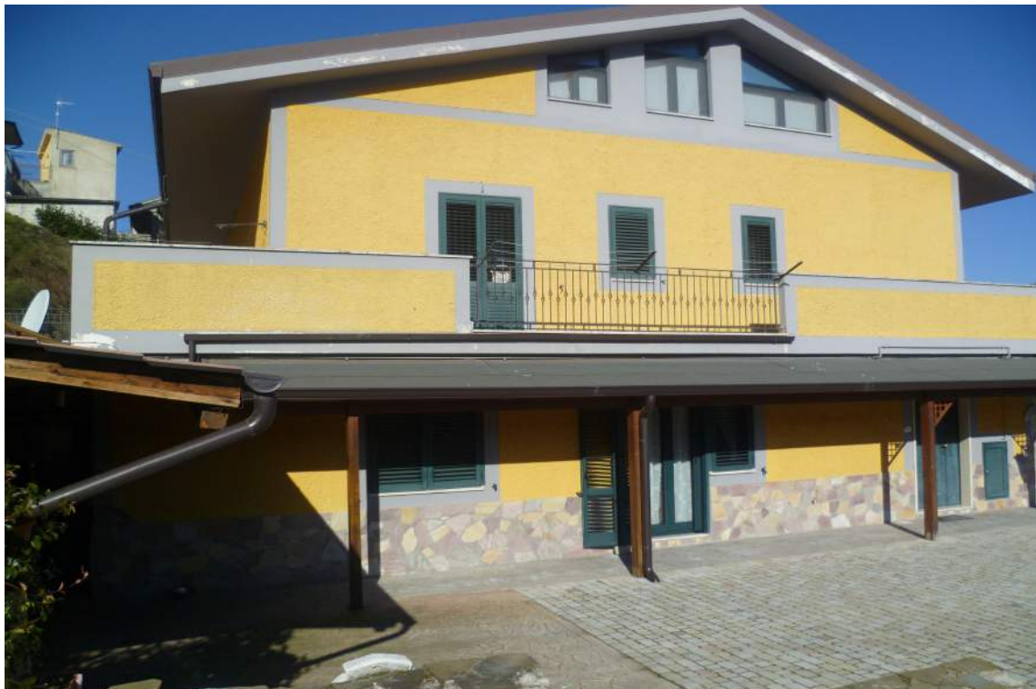
Foto1. L'accesso all'appartamento è la porta a destra. La casa si sviluppa sul piano terra e il primo piano. Il piazzale su questo fronte corrisponde alla part.664.
