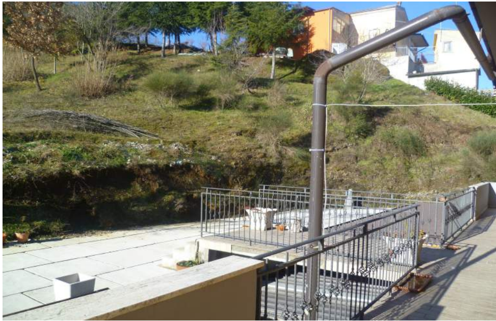
Foto3. Il retro della palazzina. Il terreno (le particelle 662 e 109) è fortemente scosceso . Sono stati messi a dimora degli abeti. Il cavedio di m3,50 a ridosso della casa è stato coperto con una tettoia che occupa tutta la lunghezza dell'immobile, creando due volumi in disponibilità rispettivamente dei due piani terra. L'accesso è dall'esterno. Al centro della foto si vede il corridoio che consente di raggiungere l'ingresso del portoncino del piano mansarda.
