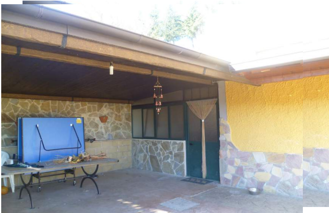
Foto 8-9-10. Accesso, interno e copertura del volume creato coprendo lo spazio tra la palazzina e il muro in c.a. di contenimento del terreno.
