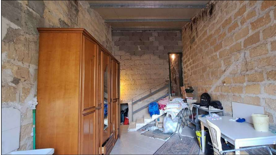
piano secondo in fase di definizione , lato Giacomo Matteotti
