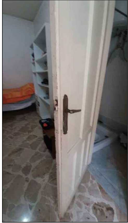
bagno piano primo
