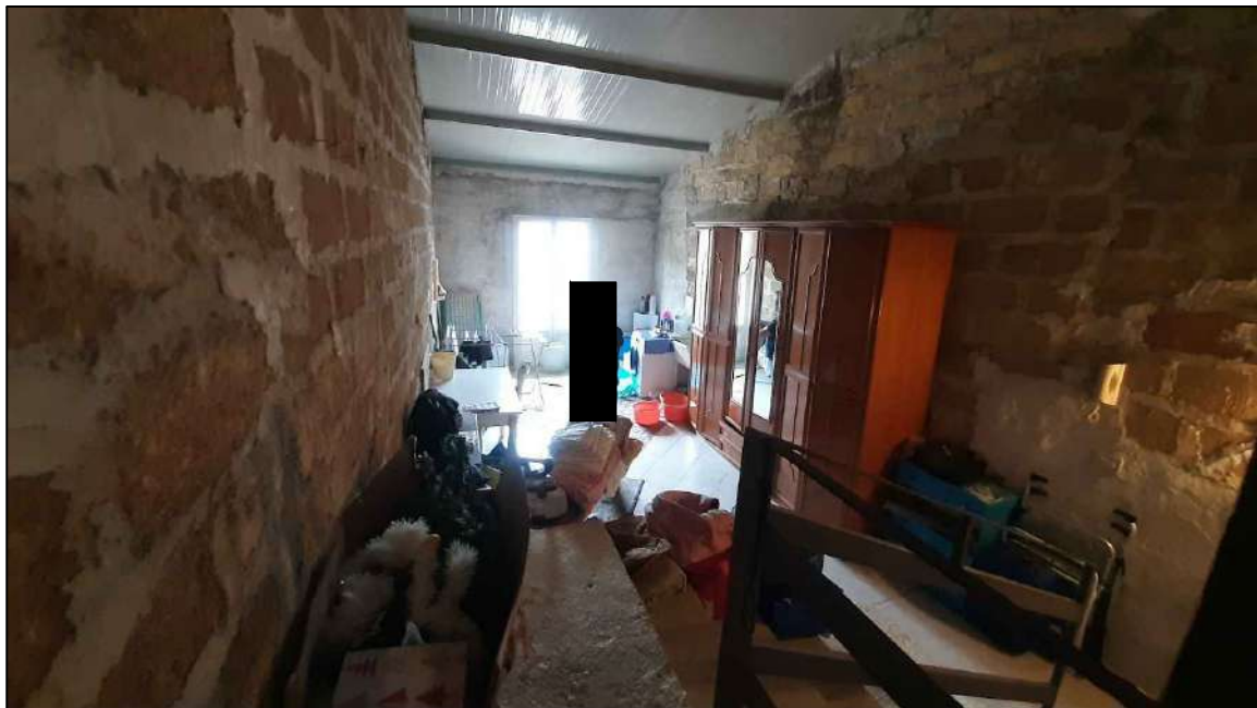
piano secondo in fase di definizione , lato Giacomo Matteotti
