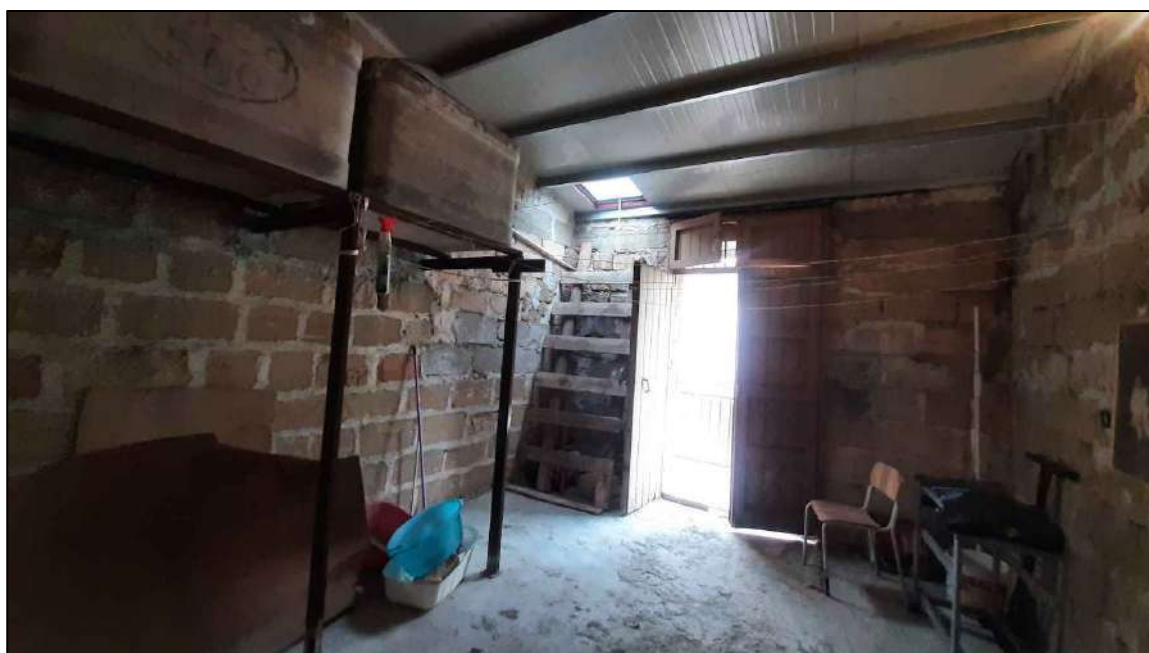
piano secondo in fase di definizione , lato Calcedonio Giordano
