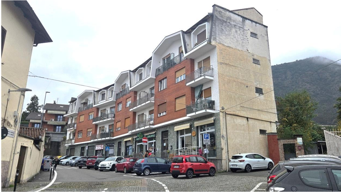
Edificio condominiale - vista da via Magenta
