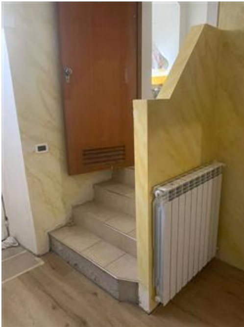
Piano terra- scala interna di collegamento
