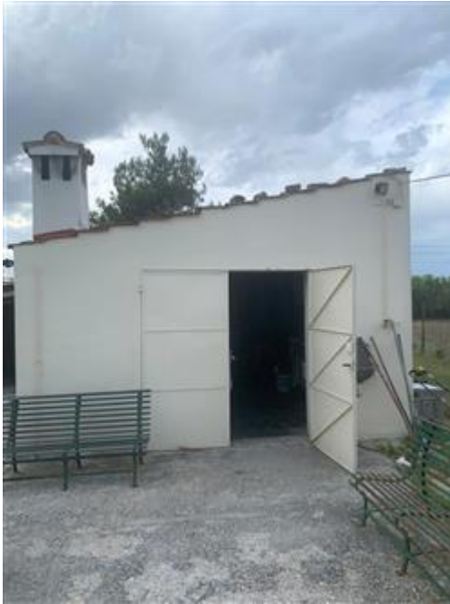
Autorimessa - foto esterno 1
