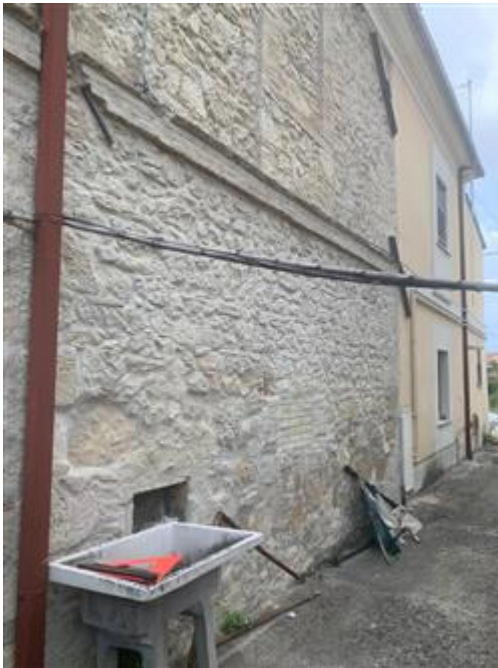
Fabbricato uso abitazione - foto esterno 3
