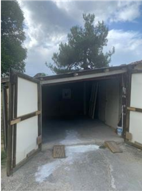
Foto Magazzino esterno 1
