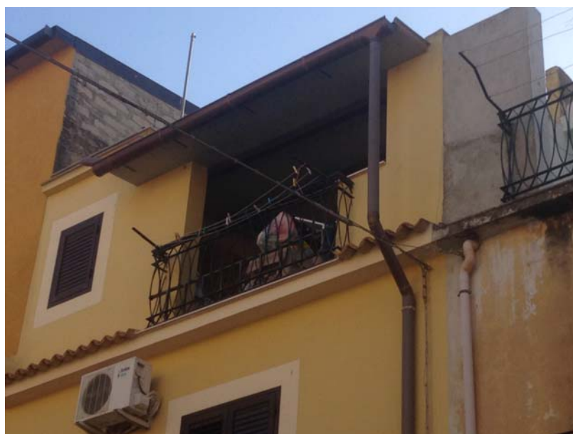
Figura 5-Copertura a Tettoia terrazza
