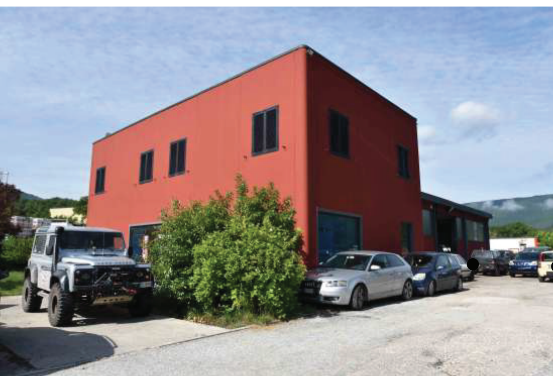
FABBRICATO A - porzione di fabbricato di due piani fuori terra. Prospetto principale lungo strada
