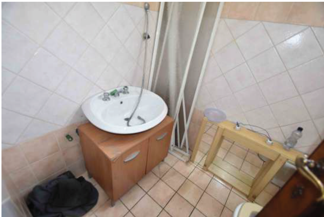
Fabbricato A - Bagno e antibagno
