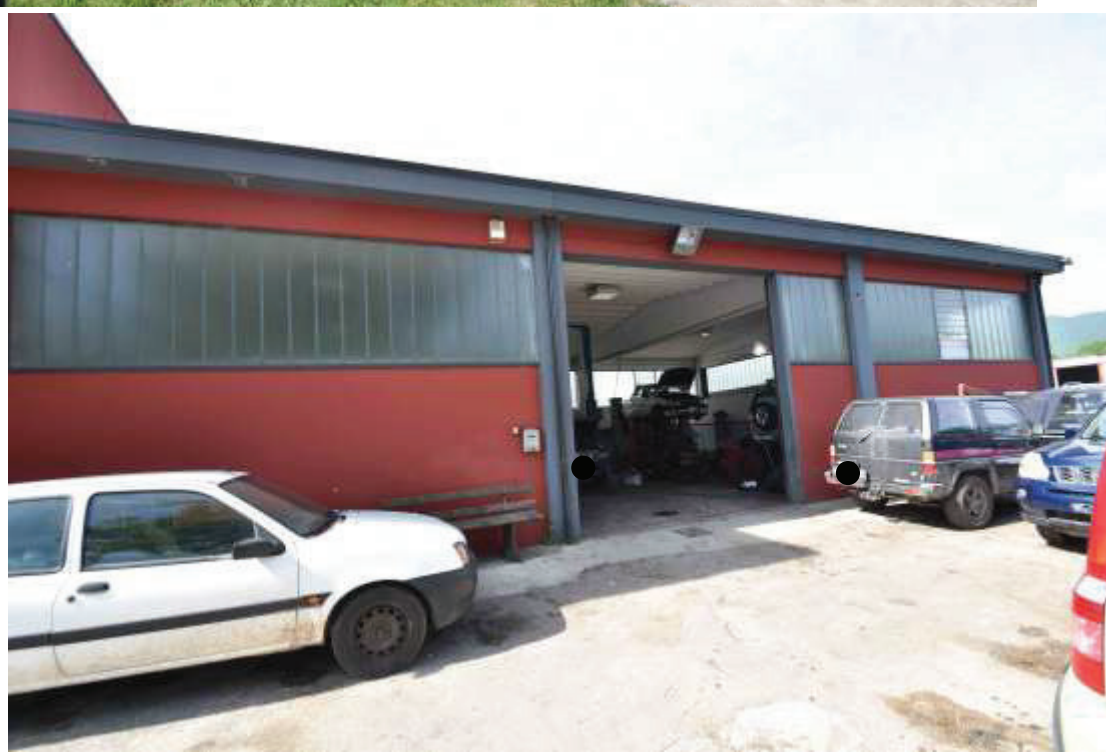
FABBRICATO A - porzione di fabbricato ad un piano fuori terra Prospetto Nord
