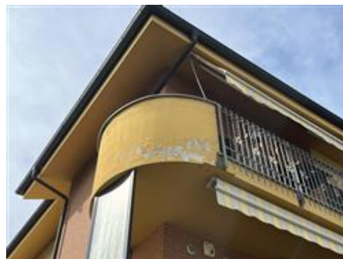
DETTAGLIO BALCONE DELL'U.I. PIGNORATA
