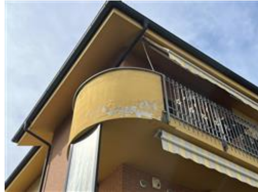
DETTAGLIO BALCONE DELL'U.I. PIGNORATA
