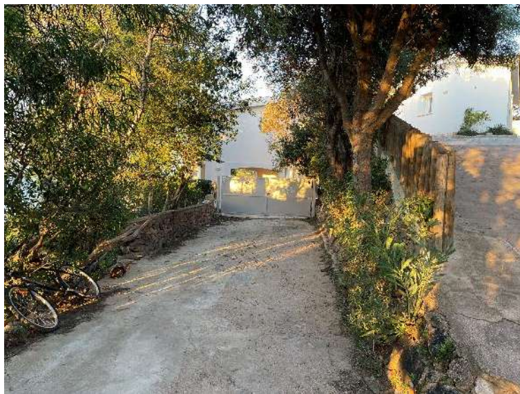
Immagine 19: Il nuovo cancello di accesso alla villa, così come rilevato dallo scrivente in un ulteriore sopralluogo del 2023.
