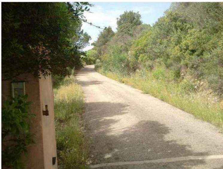
Immagine 01: Lo stradello che conduce alla villa, nello stato rilevato dall'Ing Giua in fase di redazione della perizia del 2013
