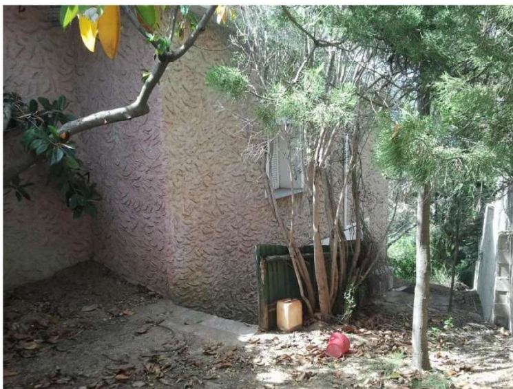
Immagine 23: Lo stato dell'area esterna adiacente alla villa rilevata dall'Ing. Giua nel 2013
