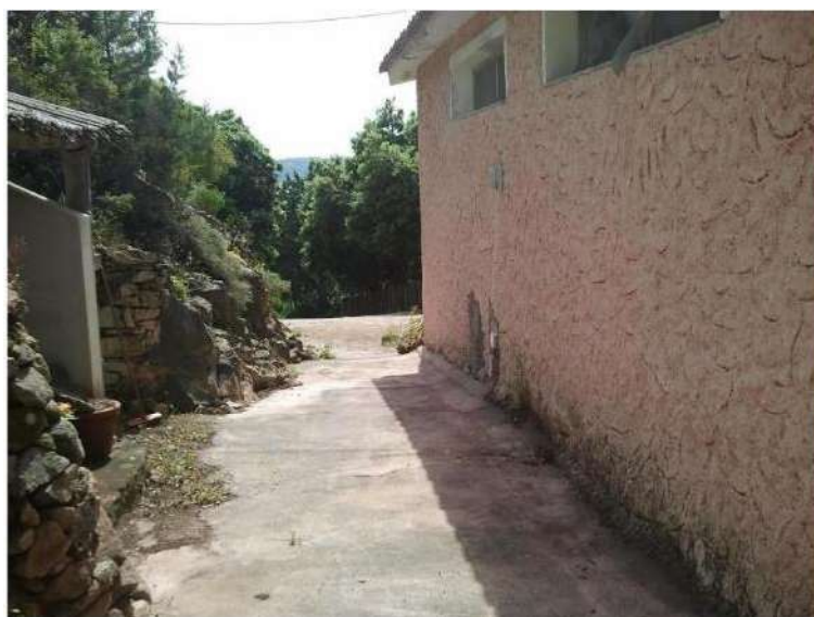
Immagine 12: Lo stato della zona barbecue rilevato dall'Ing. Giua nel 2013.
