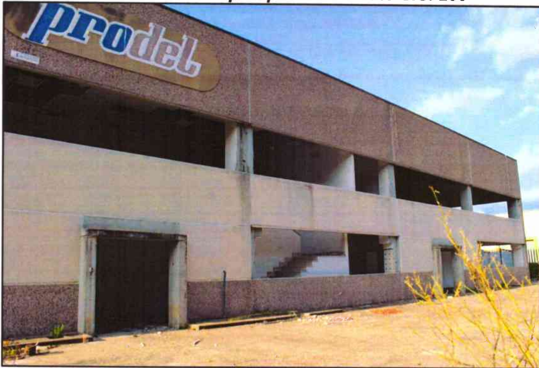
Foto 11 – prospetto Sud lato S.S. 280
