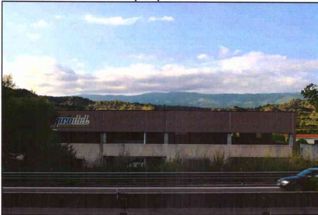
Foto 12 – prospetto Sud lato S.S. 280
