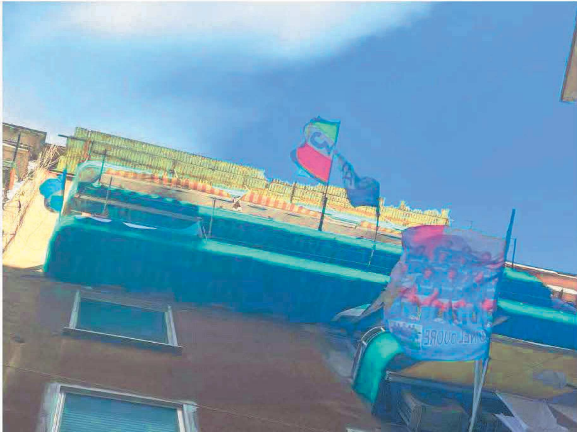
Foto 5 - Vista esterna – dettaglio balconata del cespite pignorato
