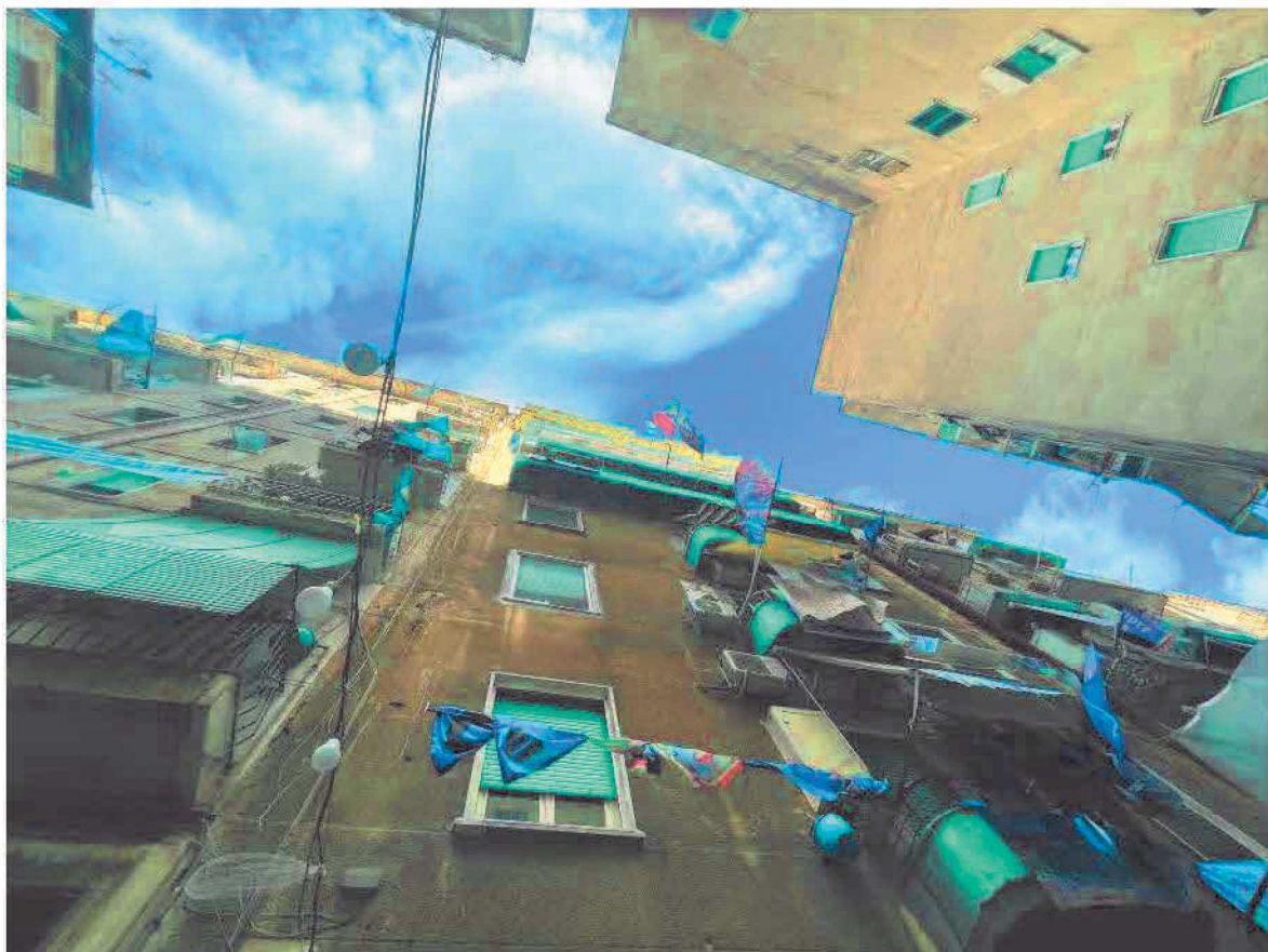
Foto 6 - Vista interna: dettaglio prospetto fabbricato di Via Emanuele De Deo n. 63
