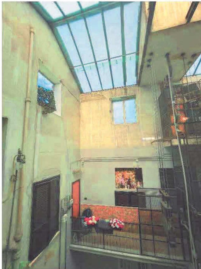
Foto 11 – Vista interna: corpo scale del fabbricato civ. n. 63 di Via Emanuele De Deo
