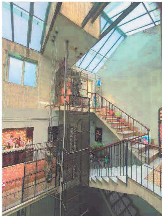
Foto 10 – Vista interna: corpo scale del fabbricato civ. n. 63 di Via Emanuele De Deo
