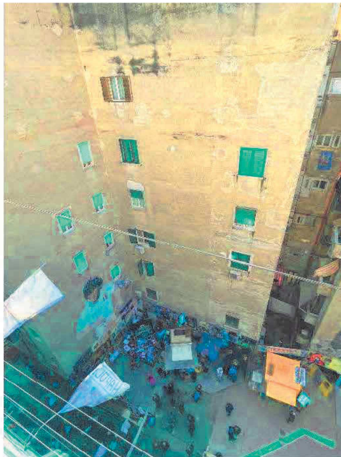
Foto 32 - Vista esterna dalla balconata
