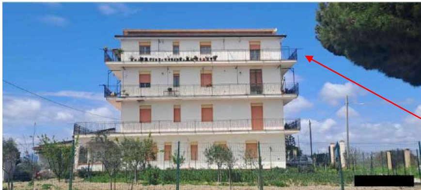
Prospetto principale – vista dalla strada Baucina – Ciminna
