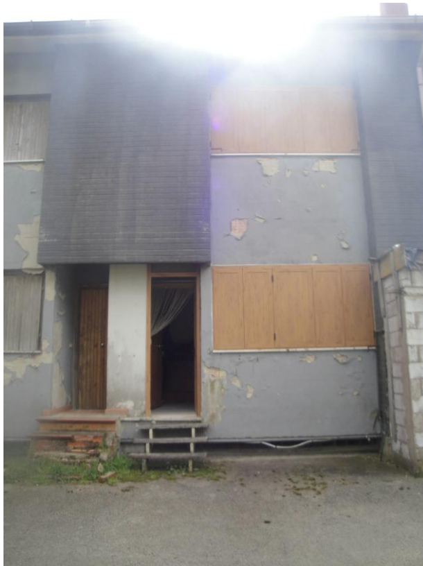
Vista del prospetto principale
