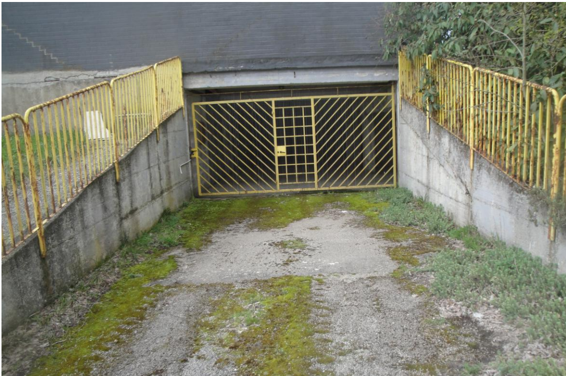
Foto 14: Box, sito in Faeto, alla contrada Rovitella (oggi Via delle Camelie) piano S.1, lotto 9, edificio 4, del complesso edilizio denominato Villaggio Turistico "San Leonardo". Rampa carrabile d'accesso con relativo cancello.
