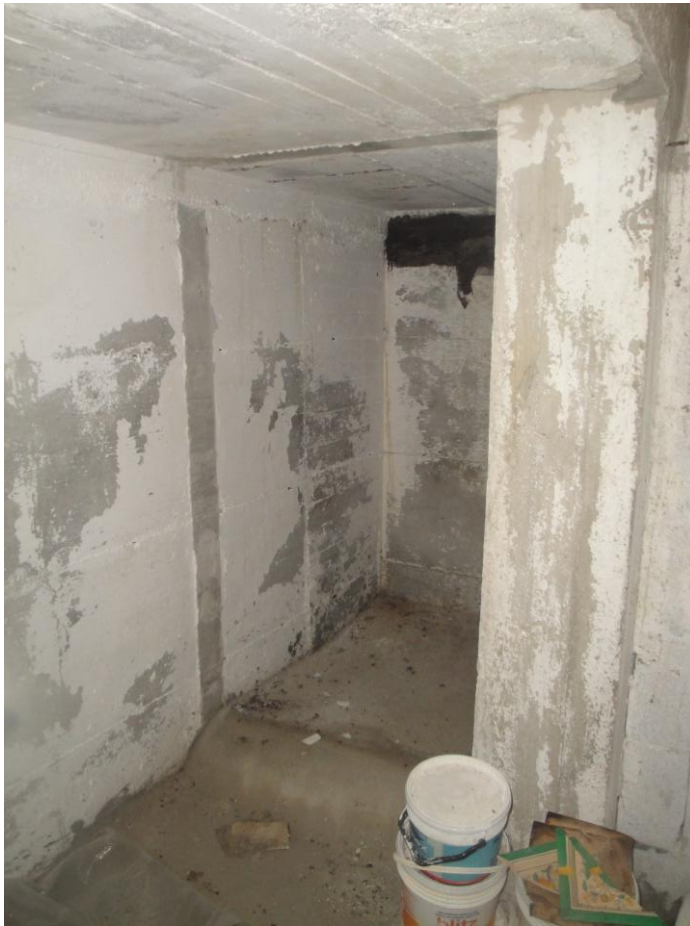
Foto 19: Box, sito in Faeto, alla contrada Rovitella (oggi Via delle Camelie) piano S.1, lotto 9, edificio 4, del complesso edilizio denominato Villaggio Turistico "San Leonardo". Interno del box. Appendice ricavata all'interno dell'intercapedine dell'autorimessa ed annessa al box.
