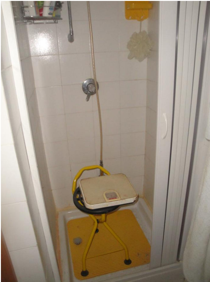
Foto 13: Appartamento con annessa area esterna, sito in Faeto, alla contrada Rovitella (oggi Via delle Camelie) piano T-1, lotto 9, edificio 4, interno 1 del complesso edilizio denominato Villaggio Turistico "San Leonardo". Interno del piano 1°. Vano bagno.
