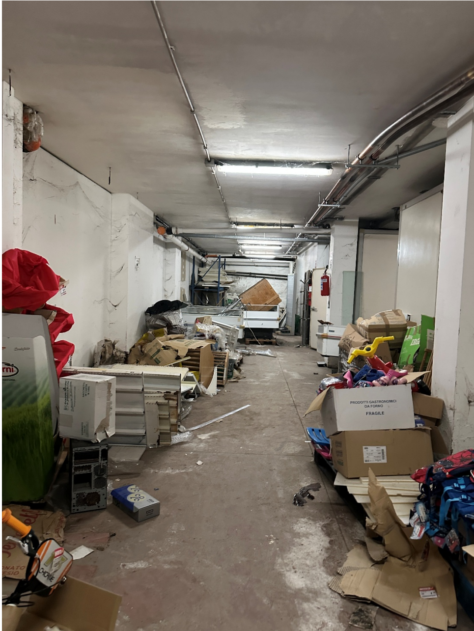
Foto 7: Interno deposito interrato.
