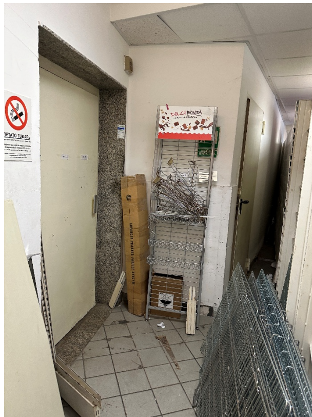
Foto 6: Zona ingresso locale interrato e montacarichi.
