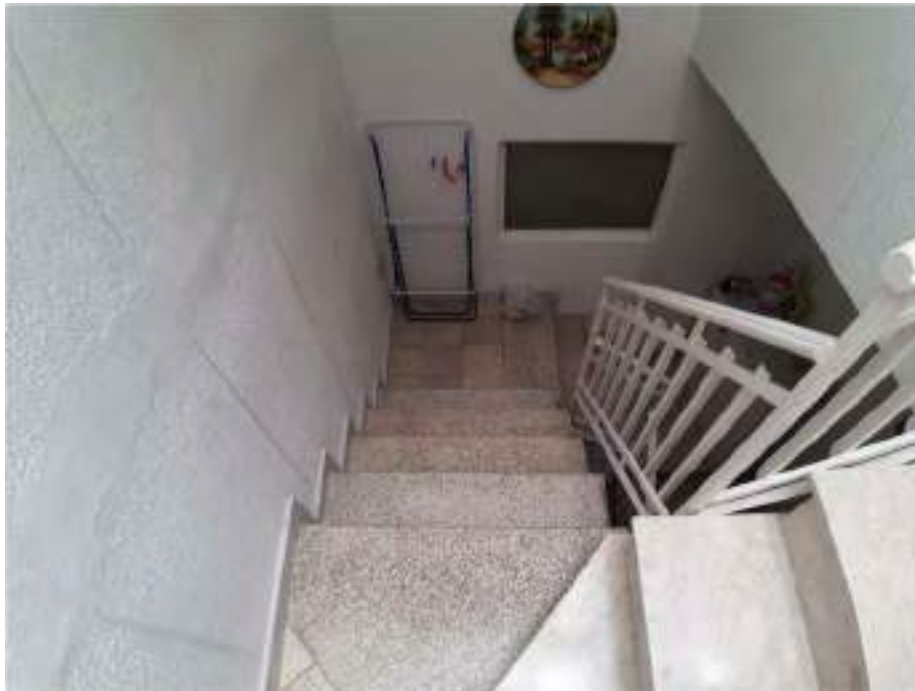
Foto n. 13: Vista scala per il piano quarto
