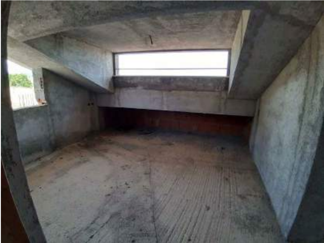
Foto n.47: Vista interno del piano primo in Cda S. Antonio
