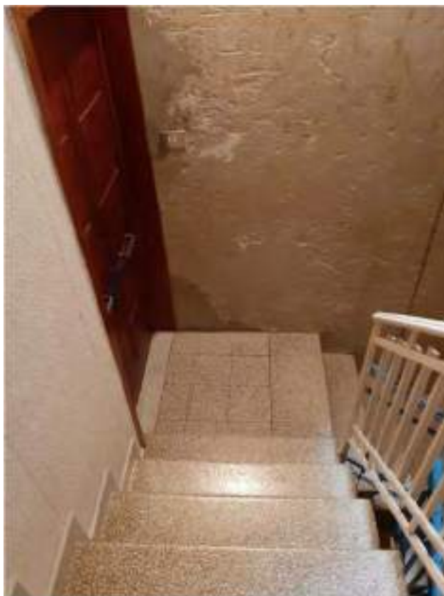
Foto n. 11: Vista delle rampe della scala condominiale
