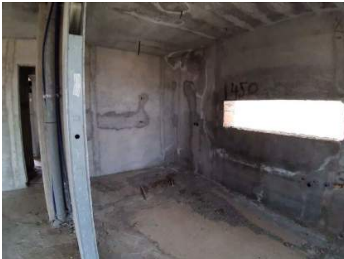
Foto n.36: Vista interno del piano primo in Cda S. Antonio
