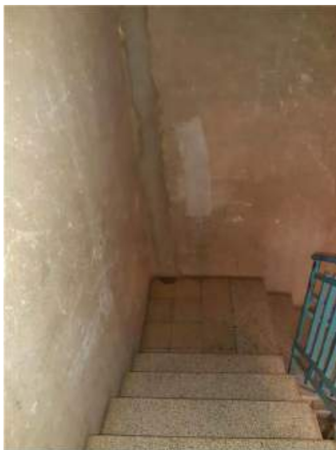
Foto n. 10: Vista delle rampe della scala condominiale
