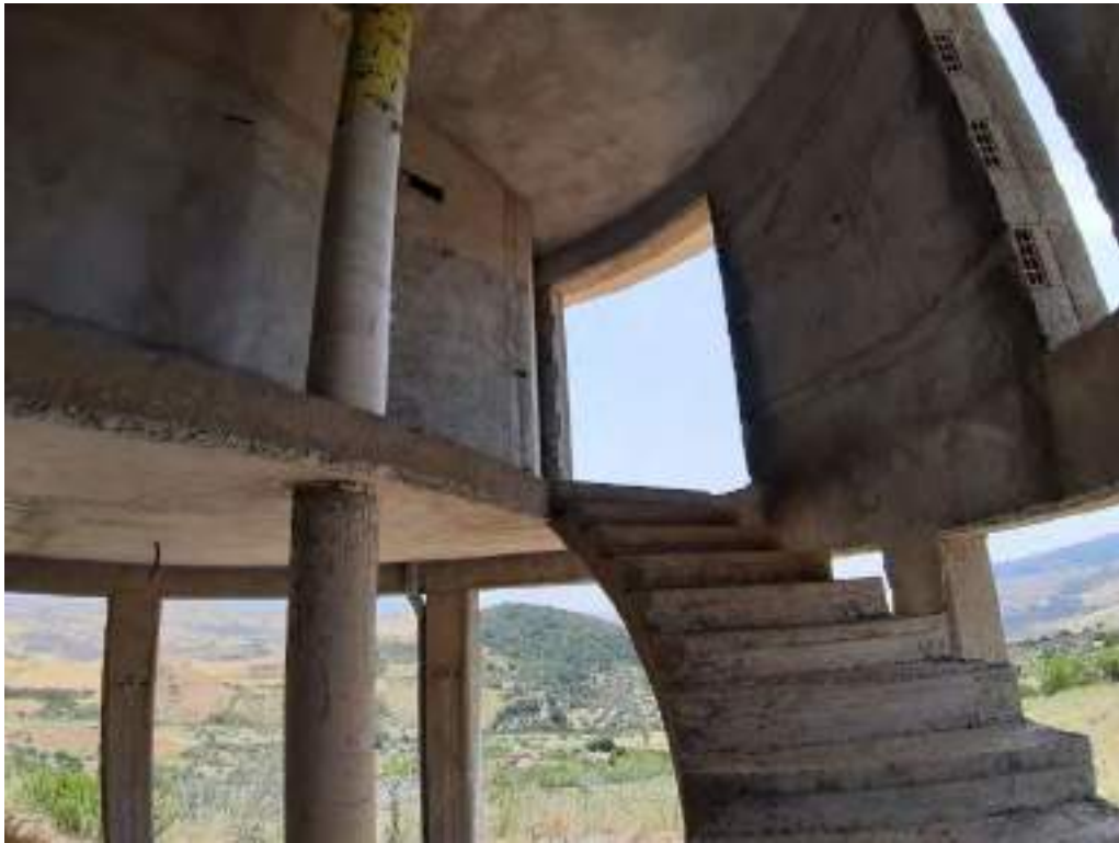
Foto n.33: Vista della scala interna tra il piano terra e primo nel fabbricato in Cda S. Antonio
