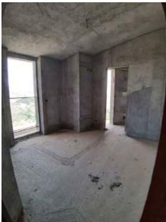
Foto n.40: Vista interno del piano primo in Cda S. Antonio
