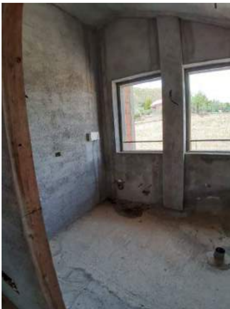
Foto n.45: Vista interno del piano primo in Cda S. Antonio
