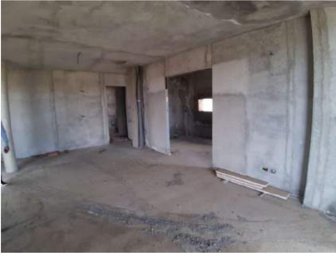
Foto n.35: Vista interno del piano primo in Cda S. Antonio
