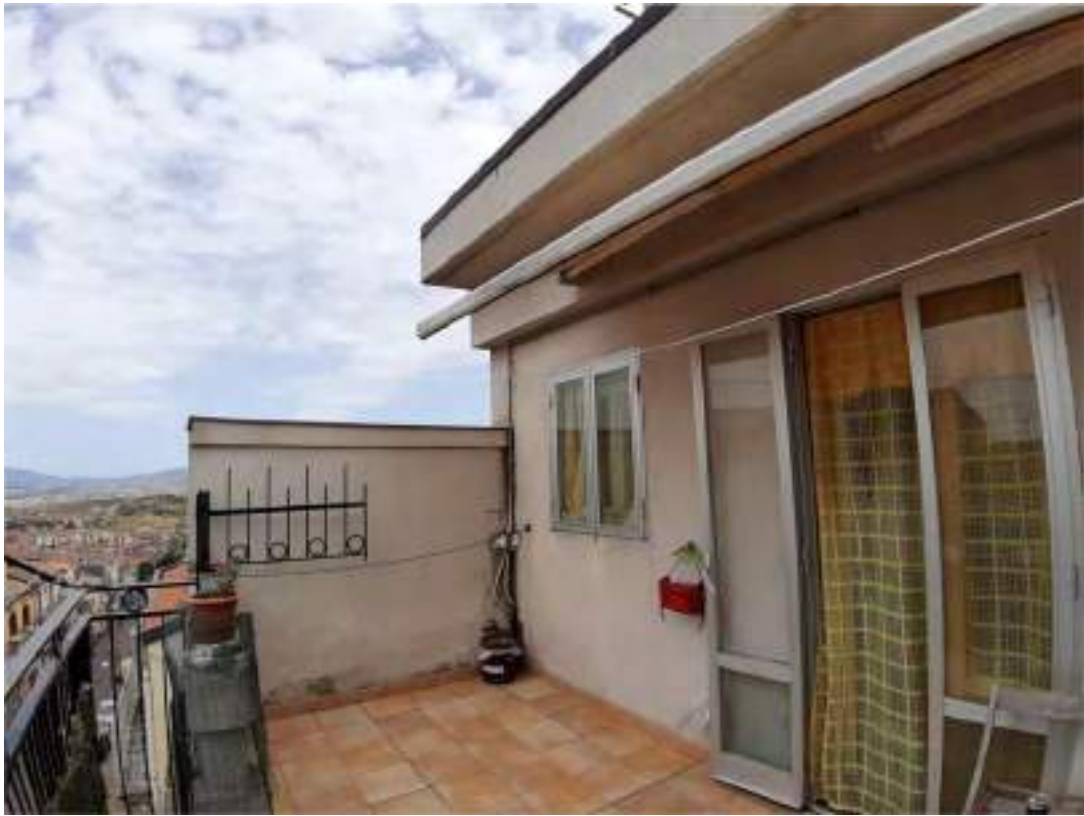
Foto n. 19: Vista del terrazzo al piano terzo –lato cucina/pranzo al piano terzo
