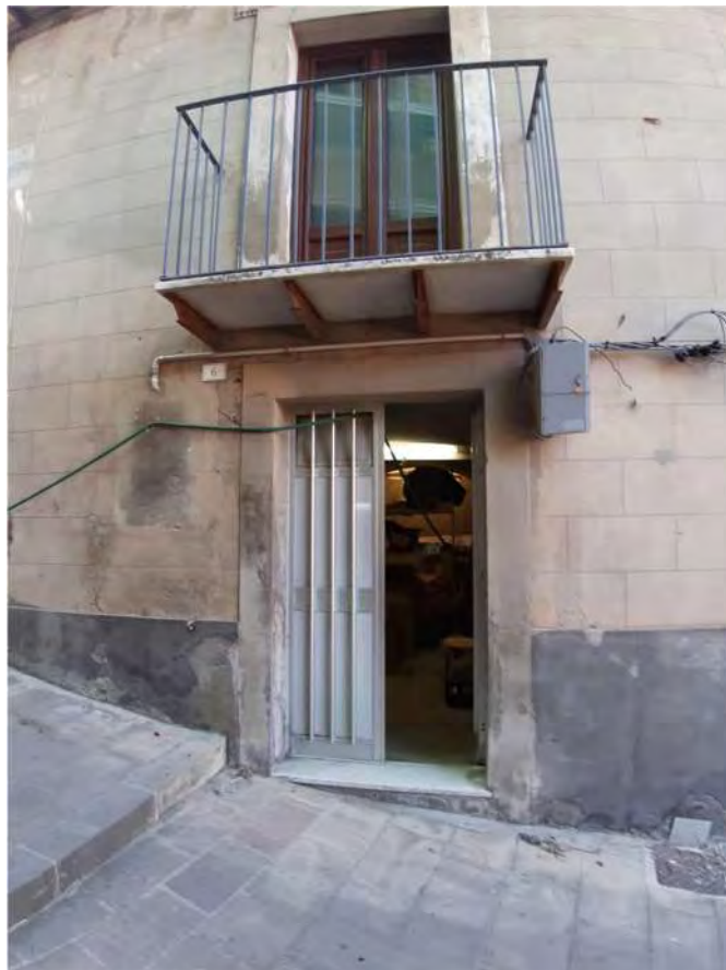
Foto n.2: Vista del Magazzino dalla Via Marchese n. 6
