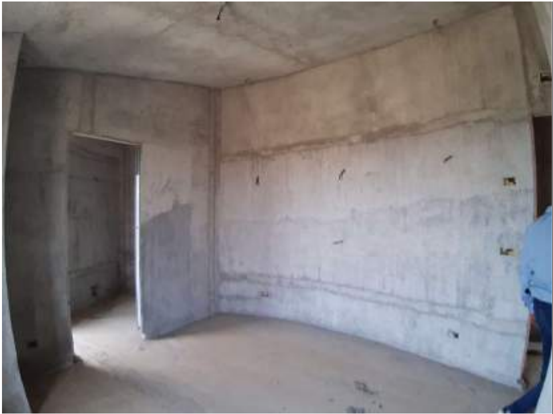
Foto n.51: Vista interno del piano primo in Cda S. Antonio
