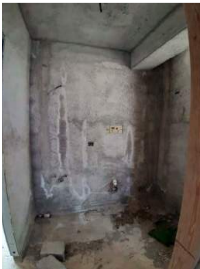
Foto n.39: Vista interno del piano primo in Cda S. Antonio
