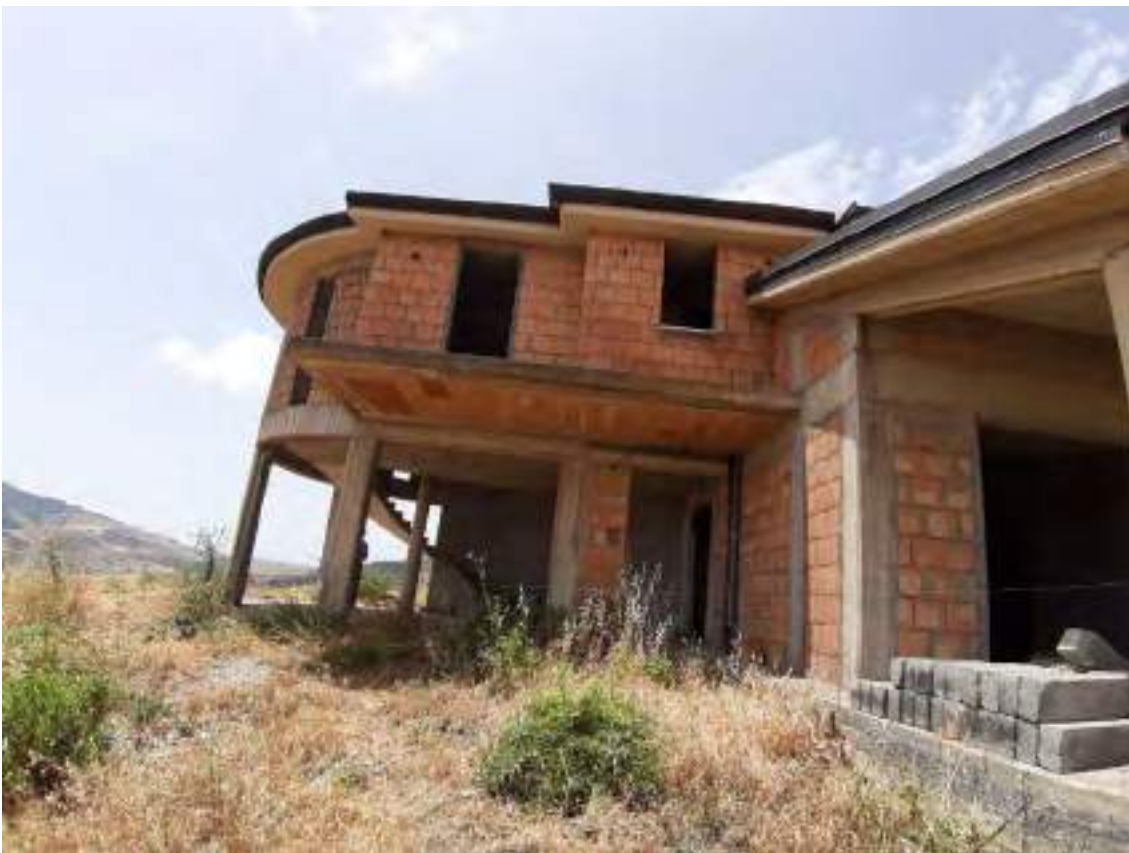
Foto n.10: Vista del Fabbricato Lato Est in Cda S. Antonio
