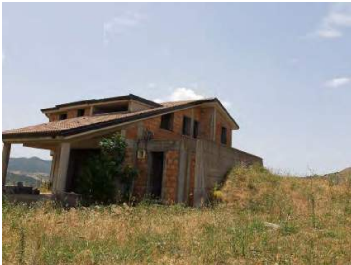
Foto n.12: Vista del Fabbricato Lato Nord Est in Cda S. Antonio
