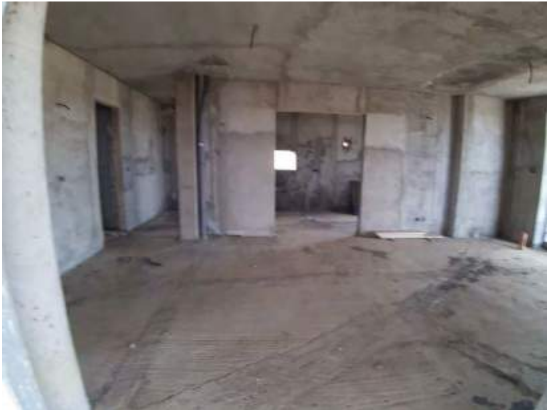
Foto n.31: Vista dell'interno del piano terra nel fabbricato in Cda S. Antonio
