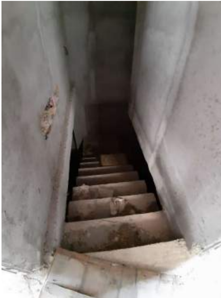
Foto n.25: Vista interno della scala per l'interrato in Cda S. Antonio
