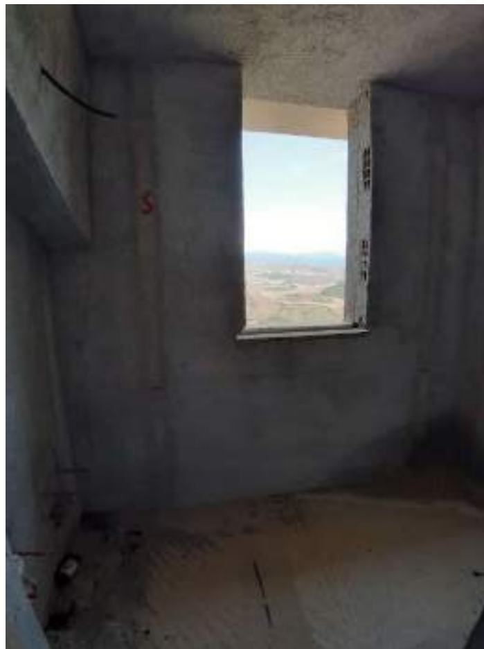
Foto n.48: Vista interno del piano primo in Cda S. Antonio
