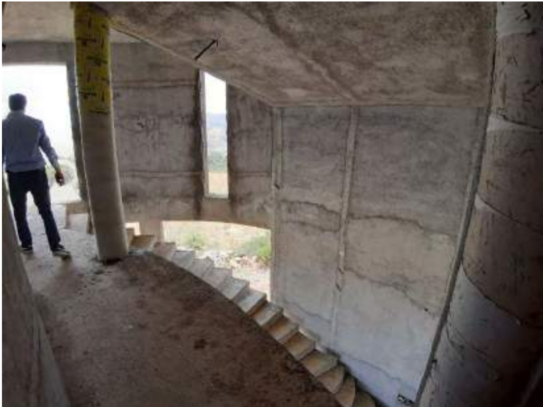
Foto n.53: Vista interno del piano primo in Cda S. Antonio
