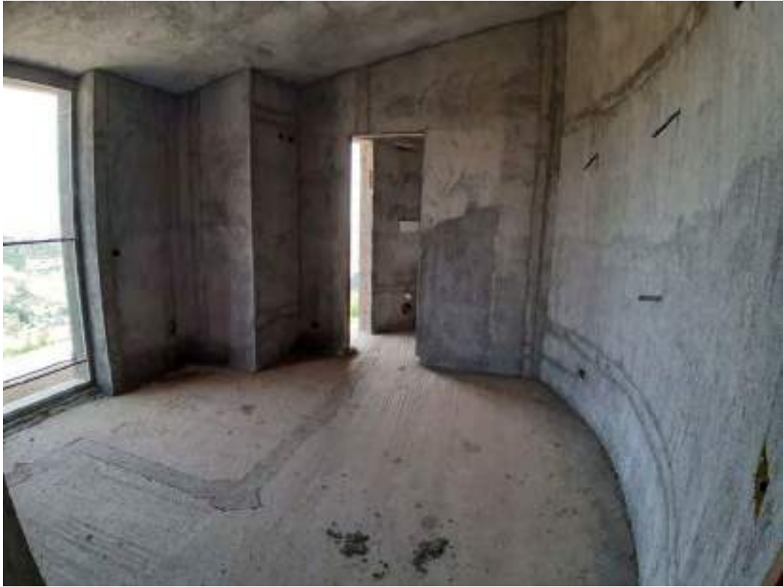
Foto n.49: Vista interno del piano primo in Cda S. Antonio
