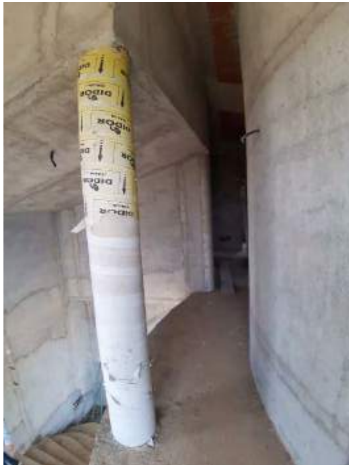
Foto n.34: Vista della scala interna dal piano primo nel fabbricato in Cda S. Antonio
