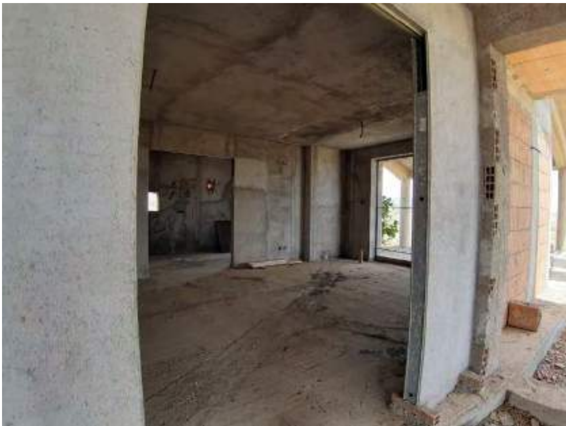
Foto n.32: Vista dell'interno del piano terra nel fabbricato in Cda S. Antonio
