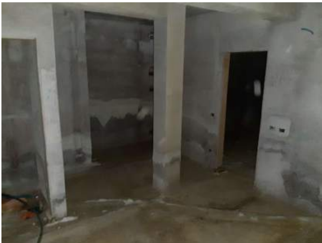
Foto n.30: Vista della cantina dell'interrato in Cda S. Antonio
