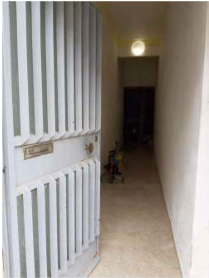
Foto n. 7: Ingresso Scala Condominiale da Via Garibaldi
