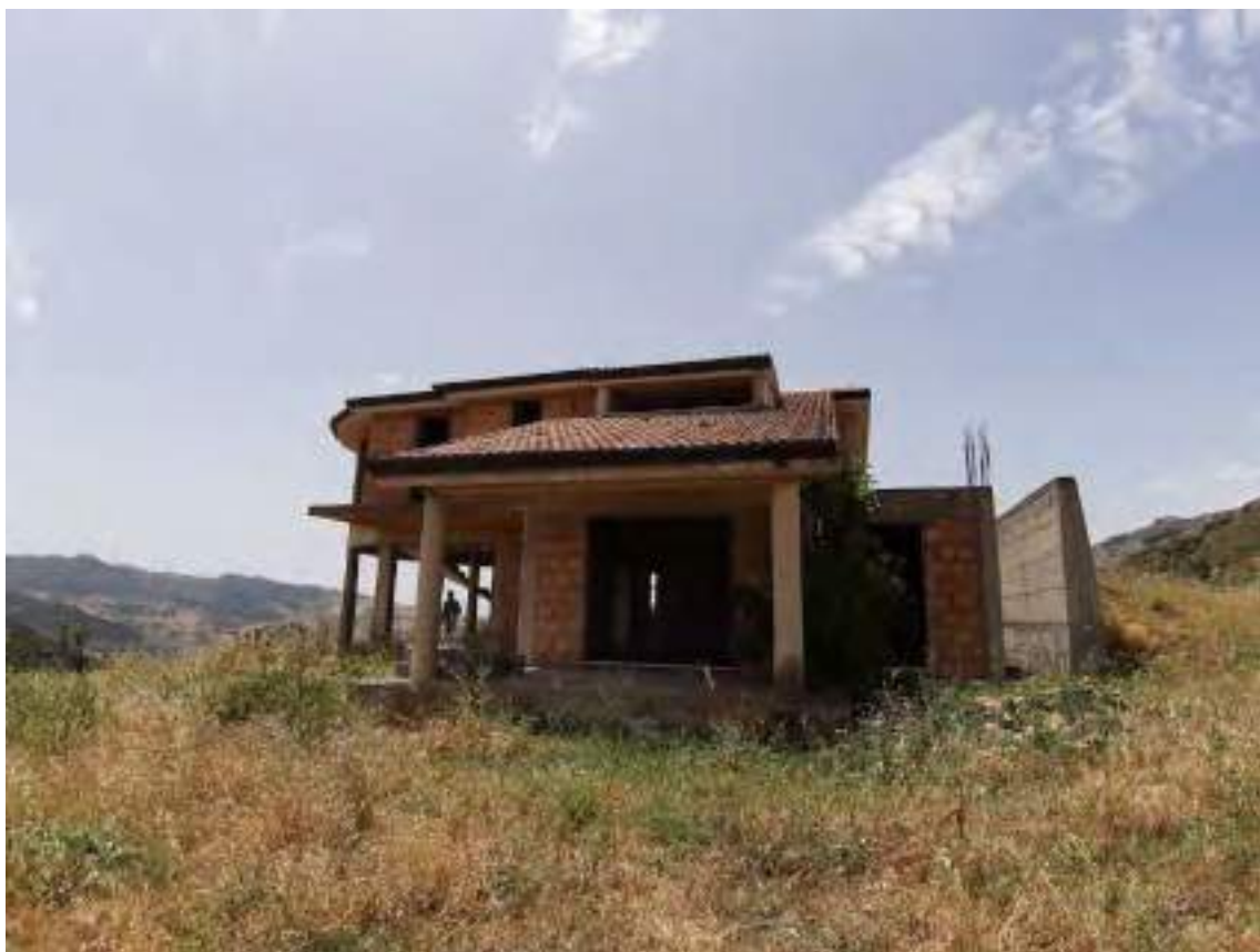
Foto n.11: Vista del Fabbricato Lato Est in Cda S. Antonio
