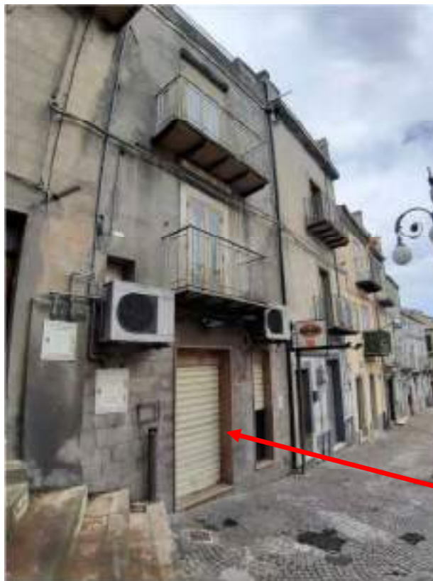
Foto n.2: Vista dalla Via Garibaldi-accesso al bar
