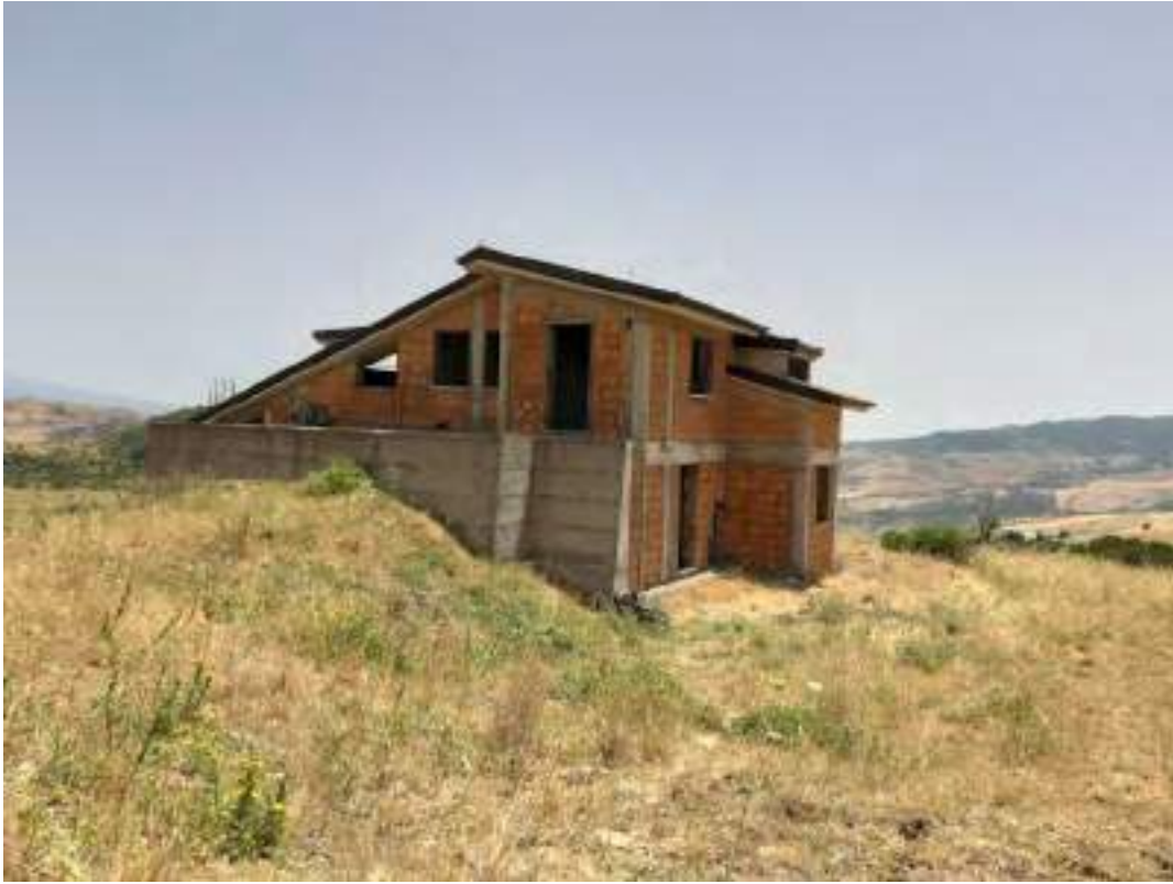
Foto n. 5: Vista del Fabbricato e terreni Lato Nord Ovest (Ingresso) in Cda S. Antonio
