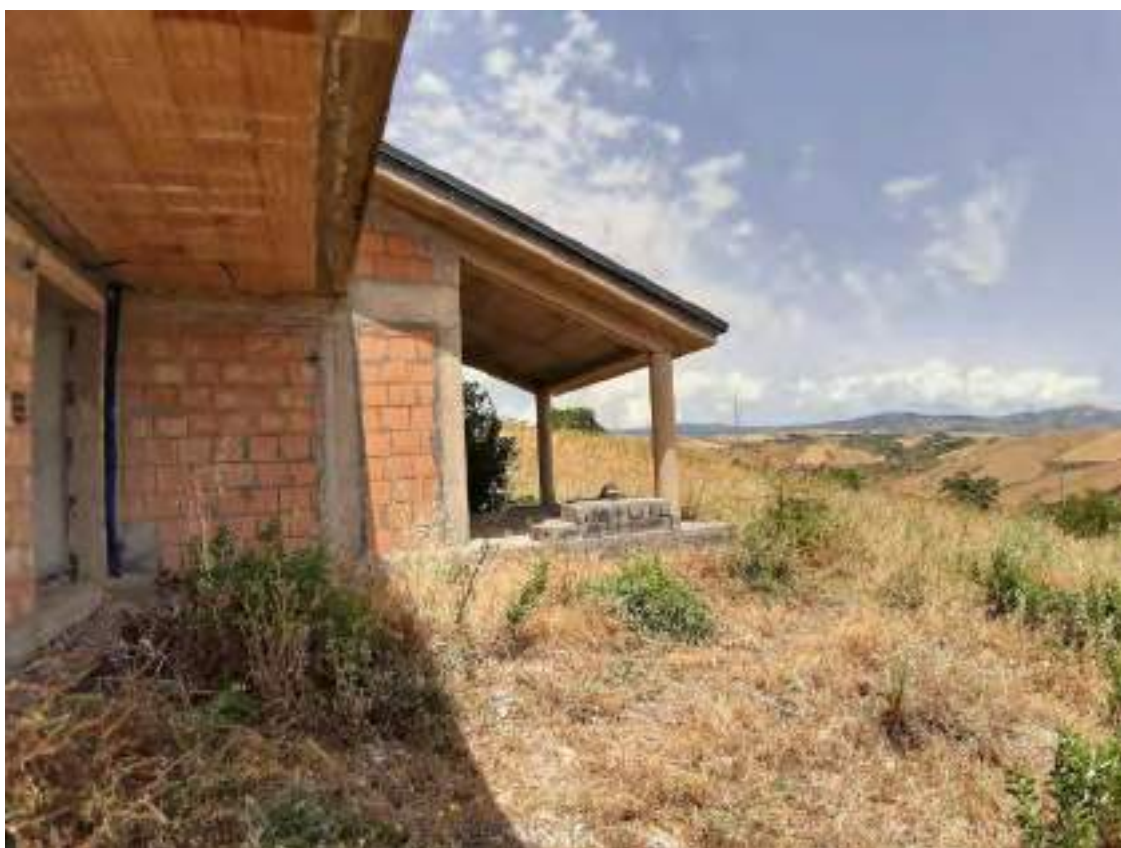
Foto n.24: Vista del fabbricato – porticato lato est in Cda S. Antonio
