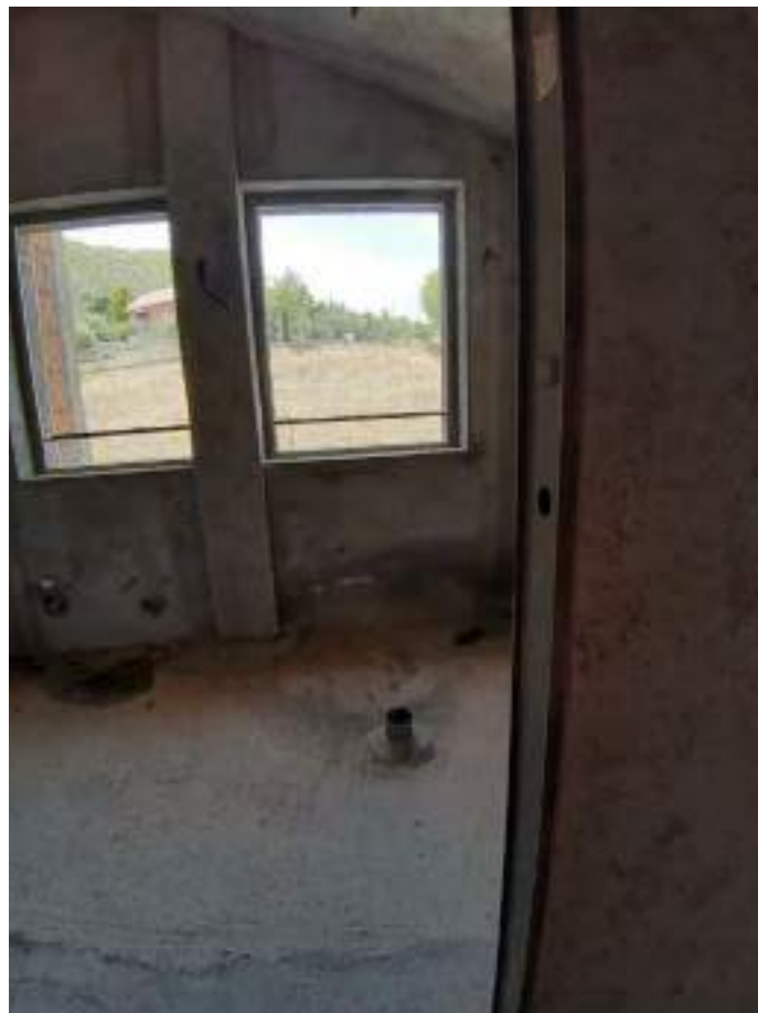
Foto n.44: Vista interno del piano primo in Cda S. Antonio
