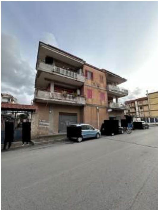
Foto n.1 – Panoramica fabbricato lato strada
