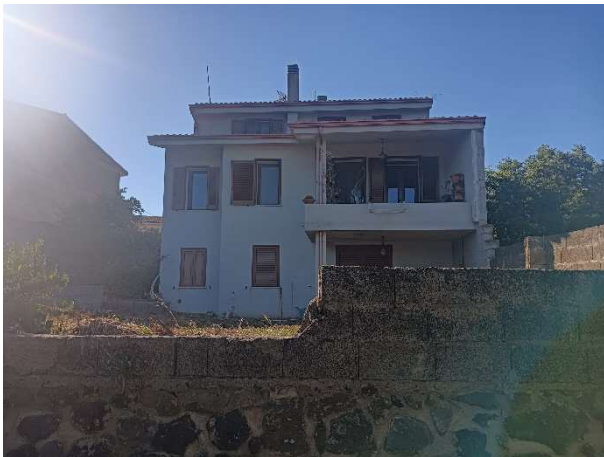
Foto 5 – Prospetto lato passeggiata Sos Molinos
