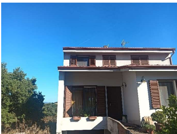
Foto 3 – Prospetto Via Mannu – Vista interno cortile
