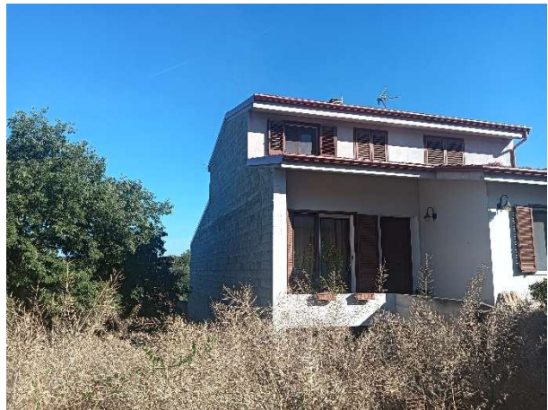
Foto 6 – Lato passeggiata Sos Molinos – Interno cortile
