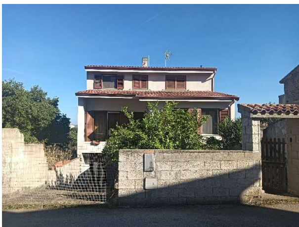
Foto 1 – Prospetto Via Mannu – Vista generale
