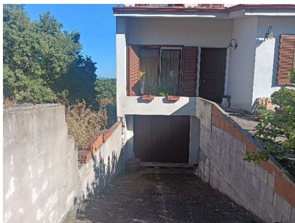
Foto 2 – Prospetto Via Mannu – Ingresso piano seminterrato
