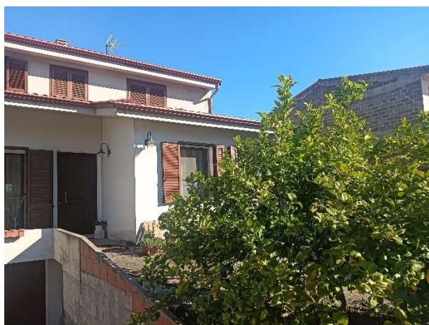
Foto 4 – Prospetto Via Mannu – Vista interno cortile
