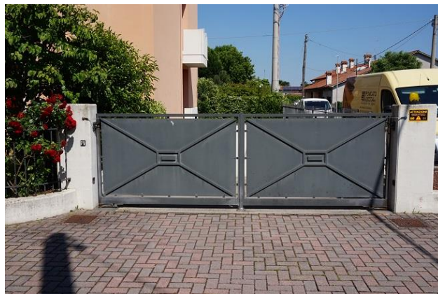
Ingresso carraio da strada privata
