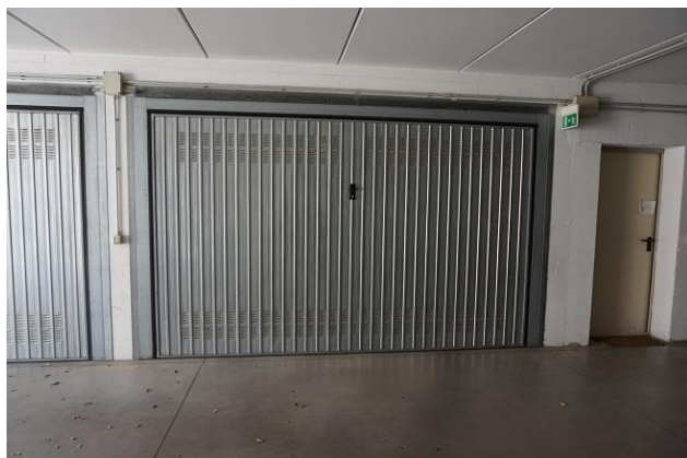
Piano Interrato – Portone accesso garage da corsia
