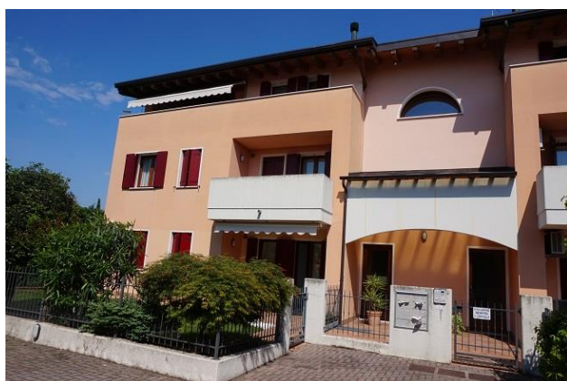
Vista fronte ovest e ingresso pedonale
