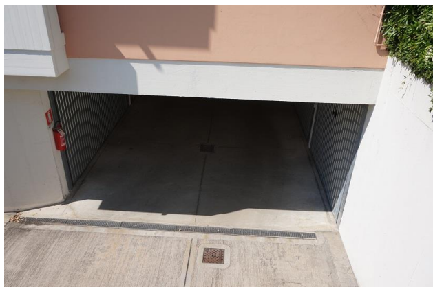
Piano Terra – Ingresso garage da scivolo
