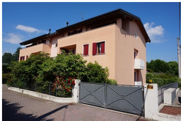
Vista fronte ovest e accesso carraio
