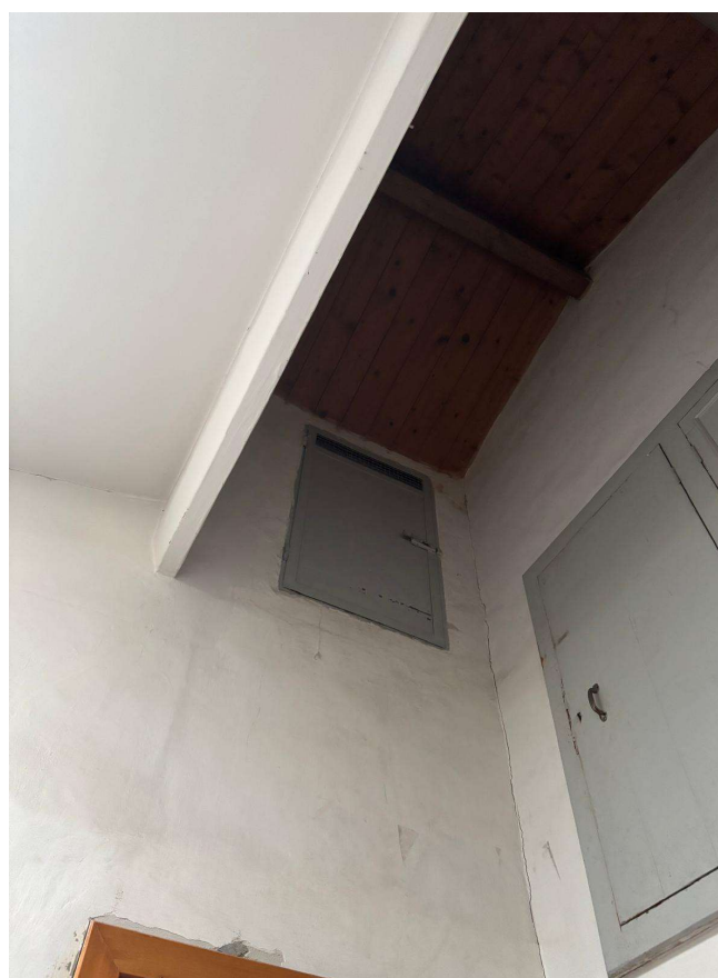
BOTOLA DI ACCESSO SOTTOTETTO
