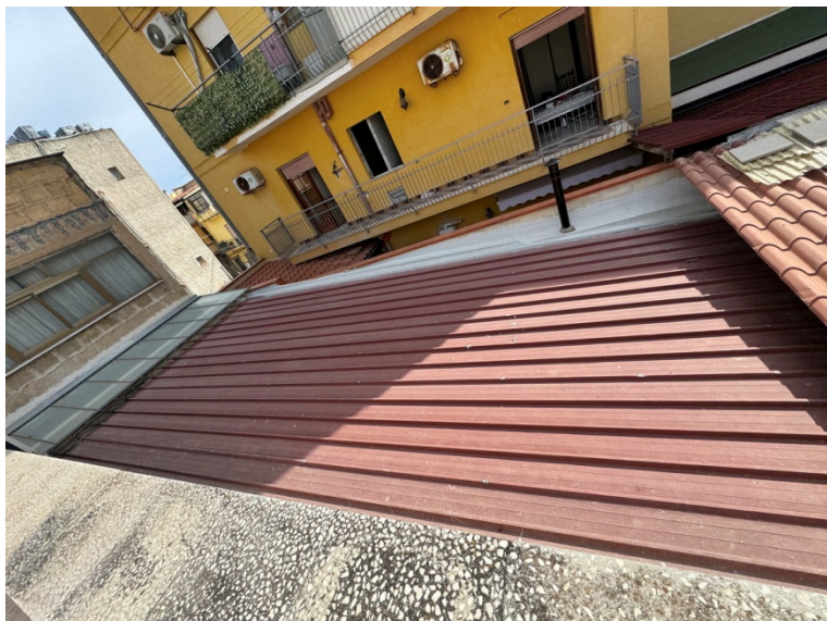
Copertura della cucina-veranda
