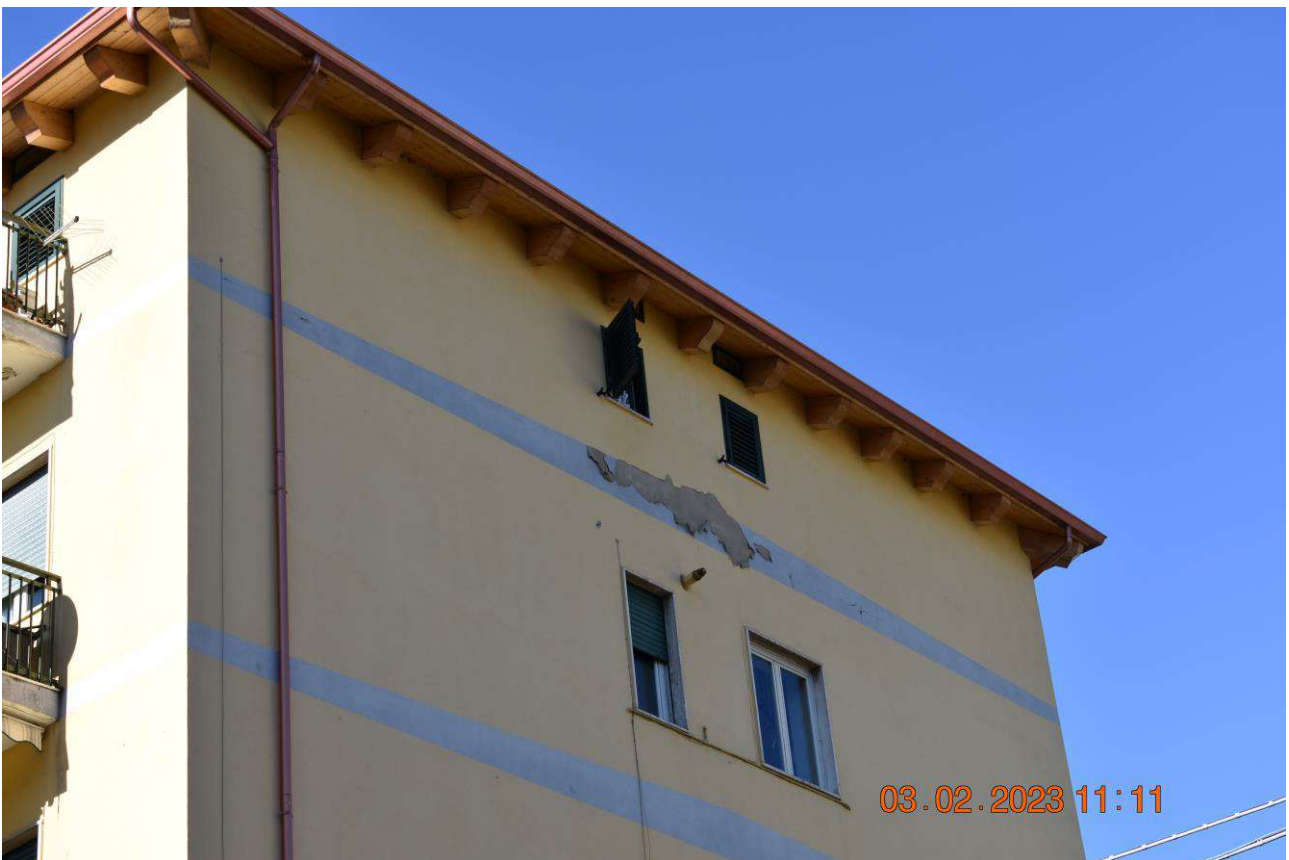
FOTO N.4: Particolare Prospetto est in corrispondenza del 4° piano sottotetto.
