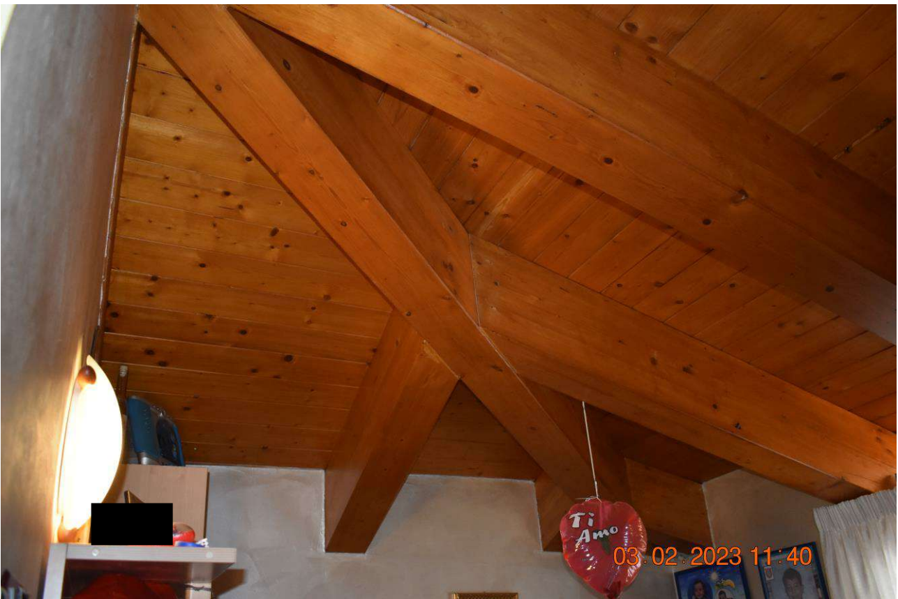
FOTO N.18: Particolare soffitto stanza da letto n.1.
