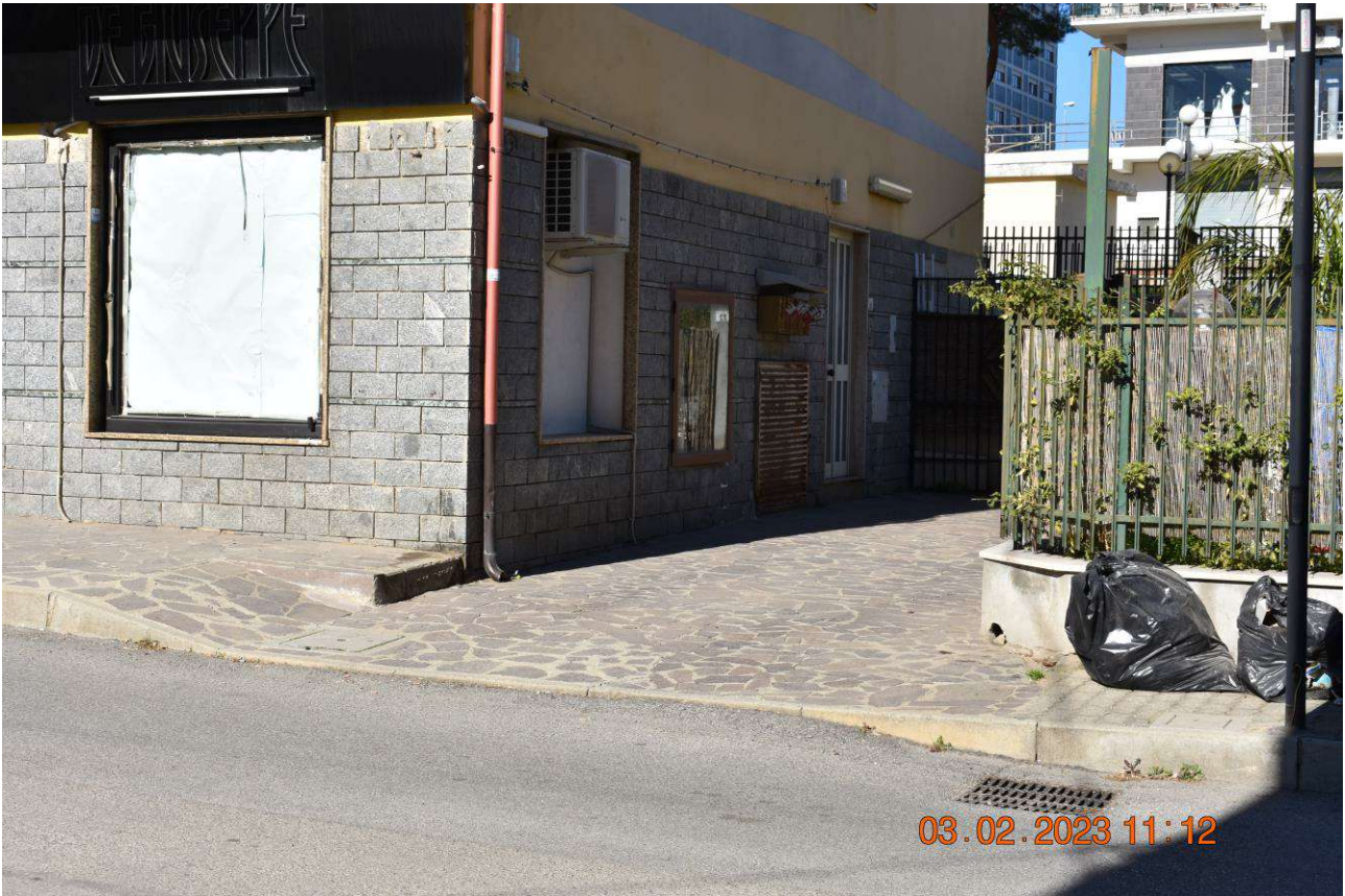
FOTO N.5: Strada privata di accesso al portone di ingresso al fabbricato.
