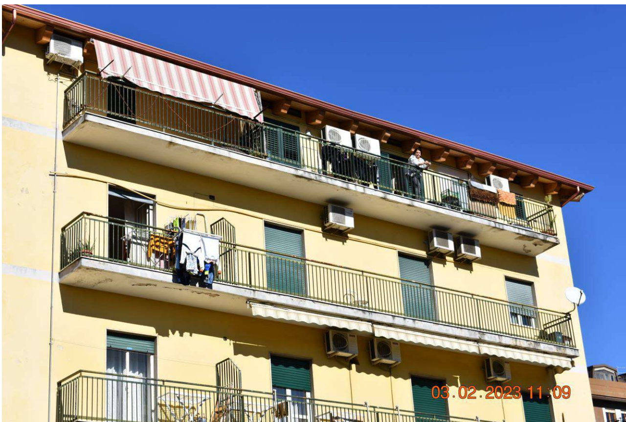
FOTO N.2: Fabbricato Via Bari n.20 Rende - Prospetto Principale sud. Particolare del 4° piano l'immobile pignorato
