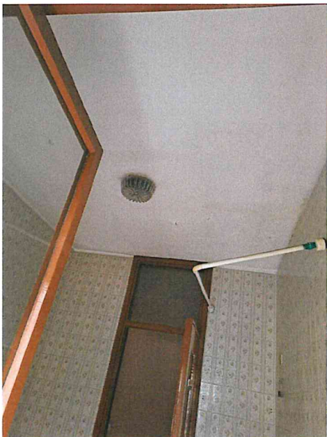
Foto 23 - Bagno particolare soffitto
