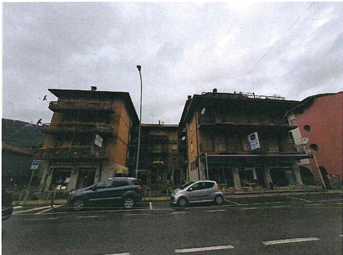
Foto 01 - Vista d'insieme edificio
