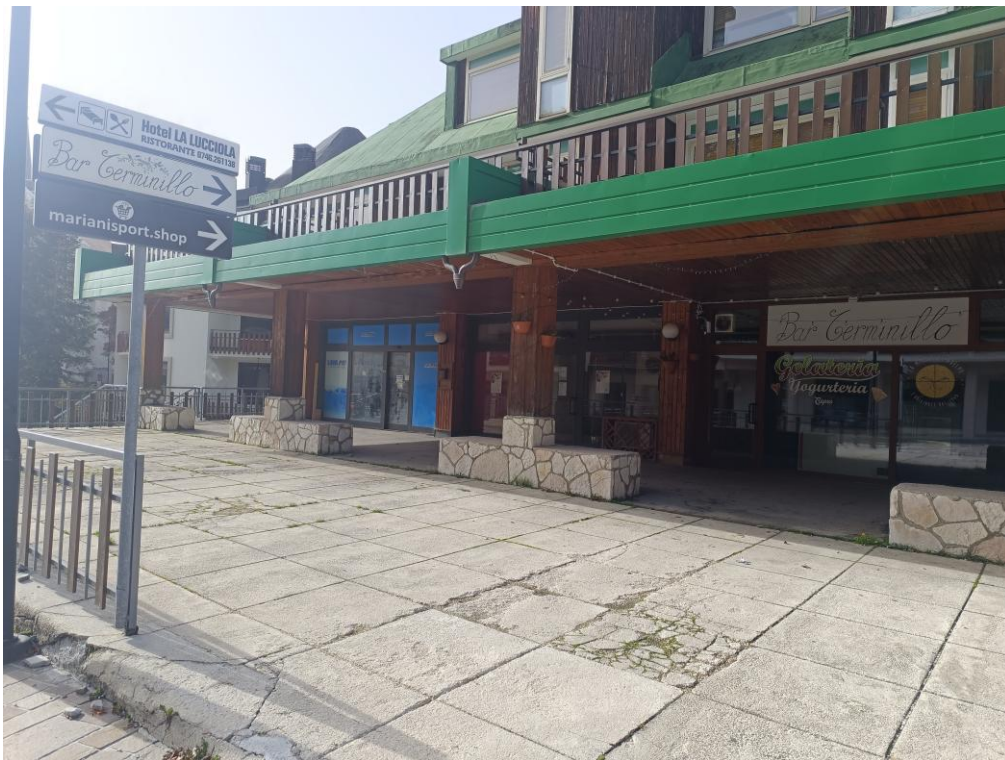
Foto n. 2 – Prospetto area porticata di accesso
