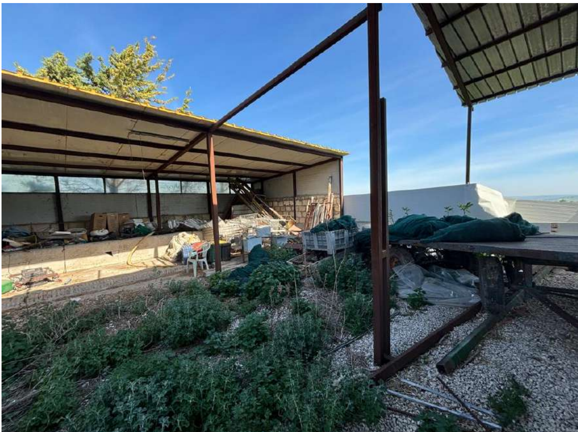
Foto n. 18 – Particolari del fabbricato fgl 22, p.lla 138 sub 1
