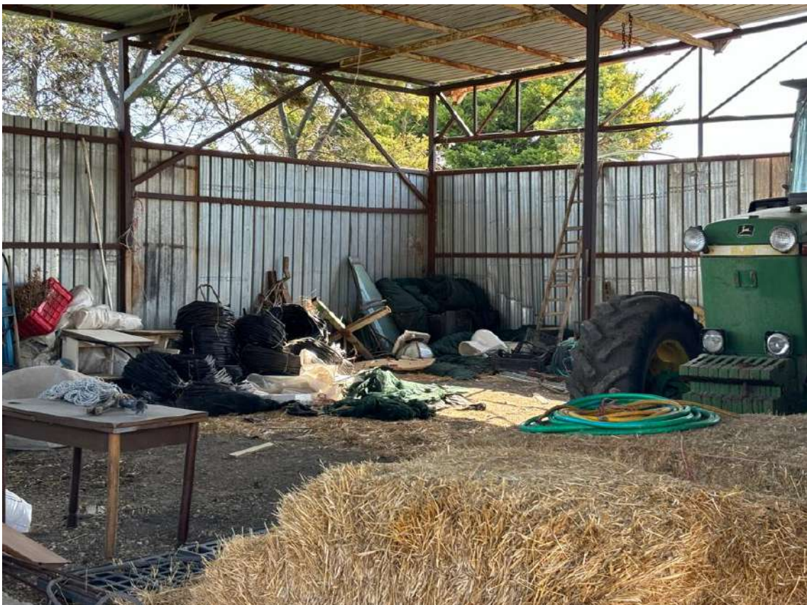
Foto n. 22 – Particolari strutturali del fabbricato fgl 22, p.la 138 sub 1
