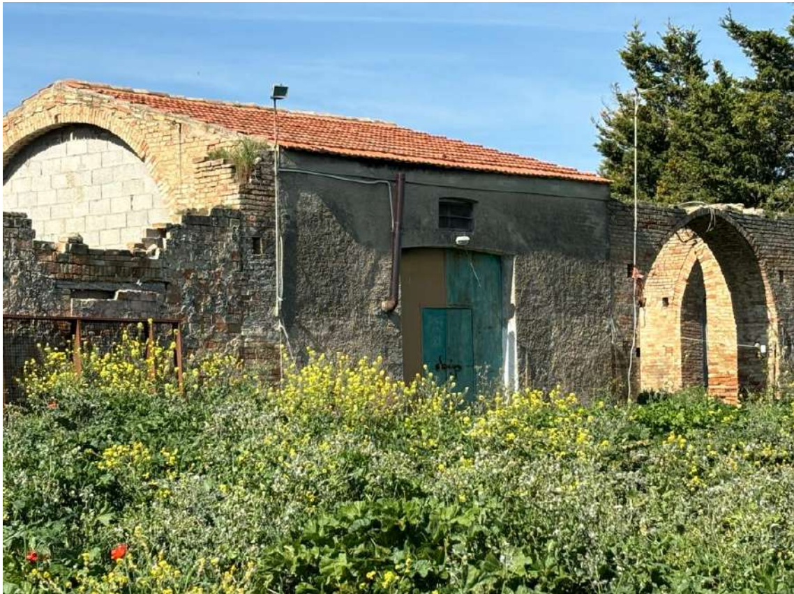
Foto n. 13 – Foglio 22, p.lla 144 (ex 116) – deposito
