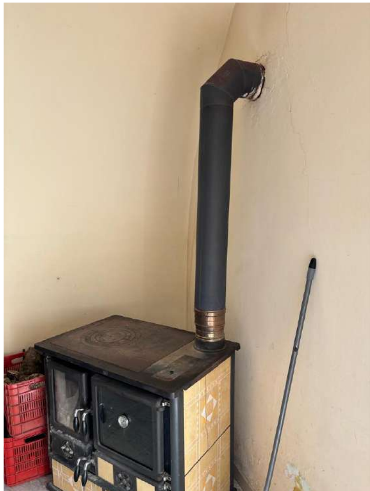
Foto n. 34 – Particolare interno dell'immobile fgl 22, p.la 145 (ex 117)
