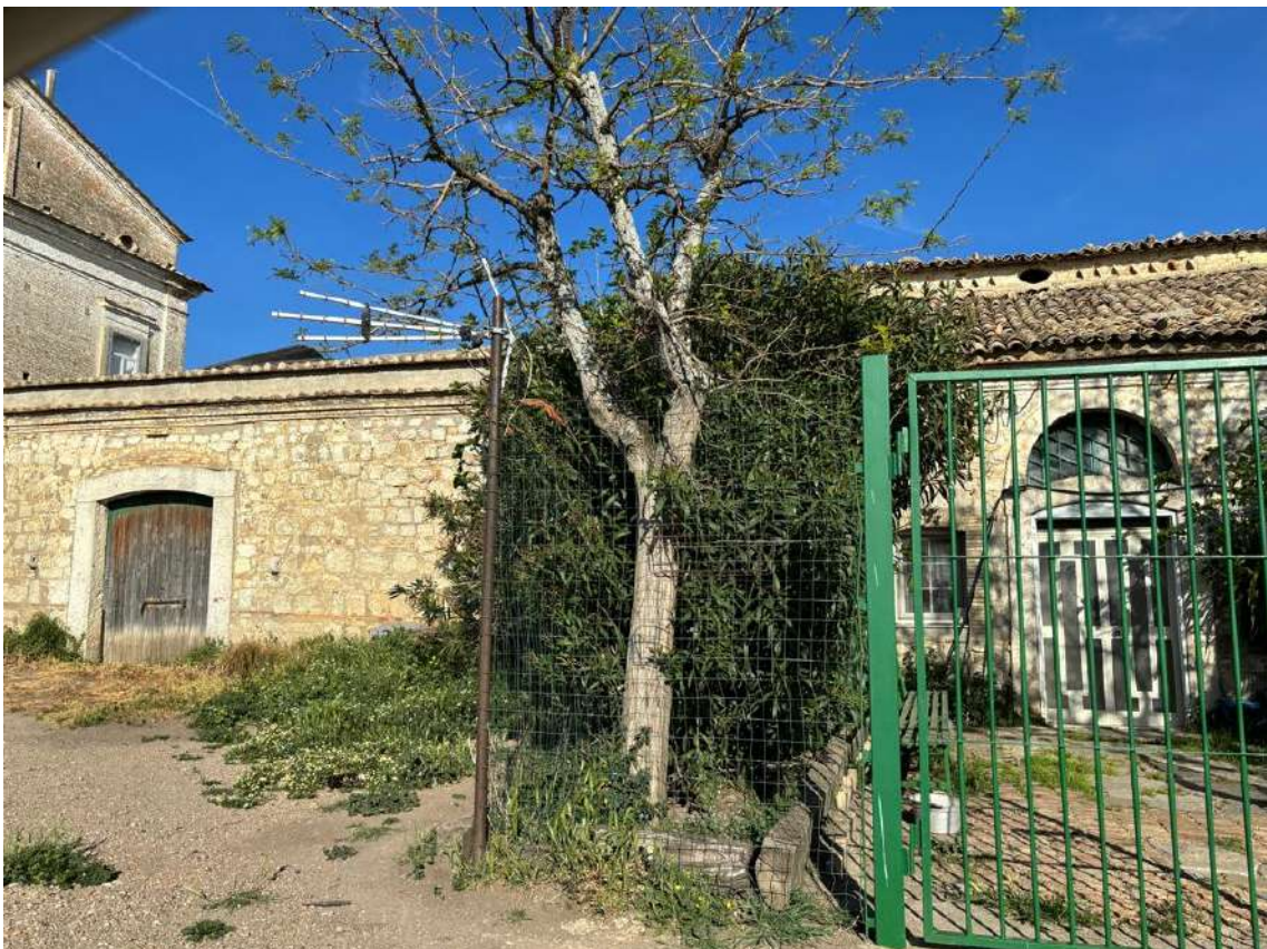
Foto n. 26 – Prospetto dei fabbricati di cui al fgl 22, lungo la S.C. Crocetta
