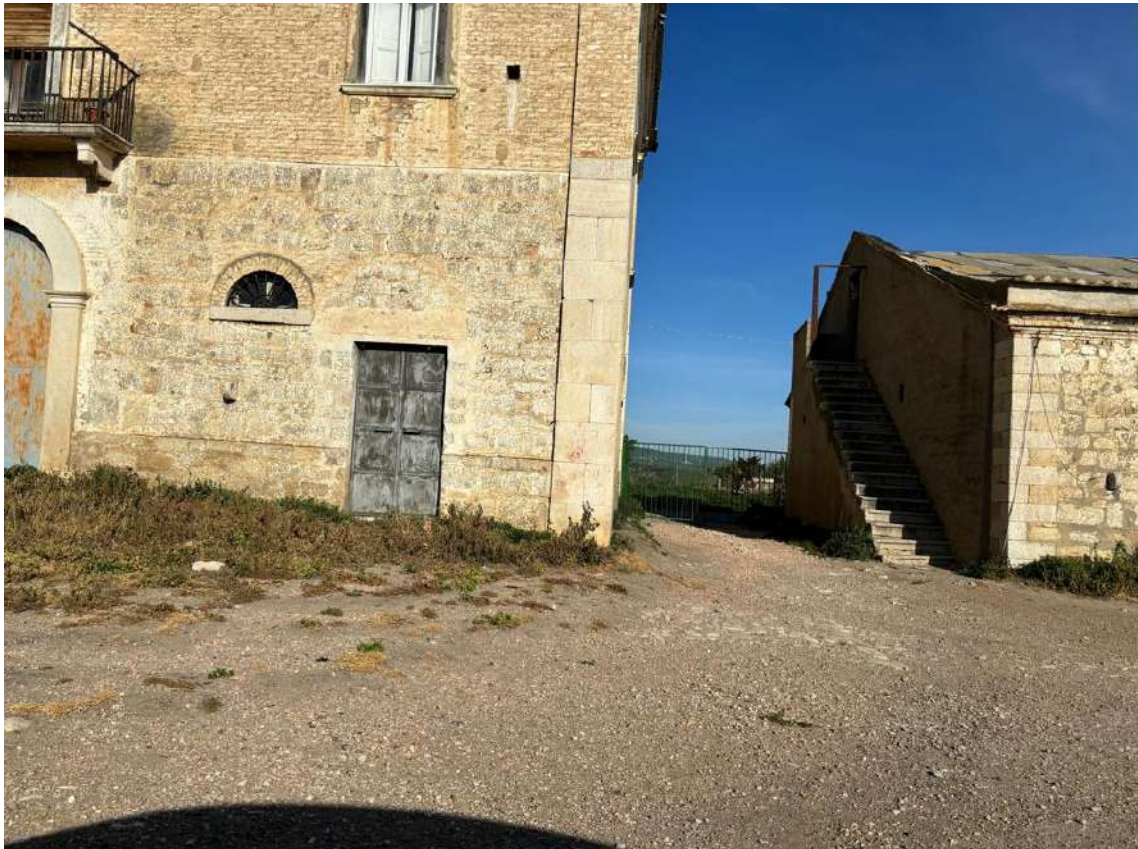
Foto n. 27 – Prospetto dei fabbricati di cui al fgl 22, lungo la S.C. Crocetta
