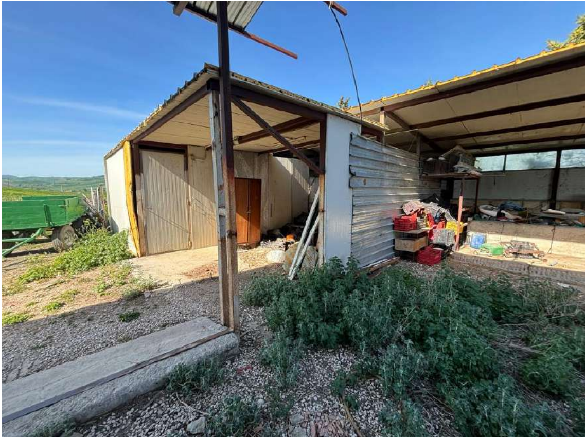
Foto n. 17 – Particolari del fabbricato fgl 22, p.lla 138 sub 1
