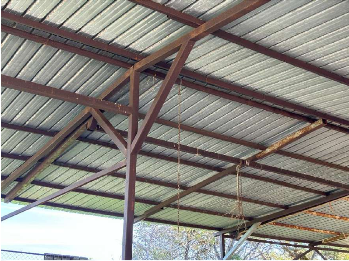
Foto n. 21 – Particolari strutturali del fabbricato fgl 22, p.la 138 sub 1
