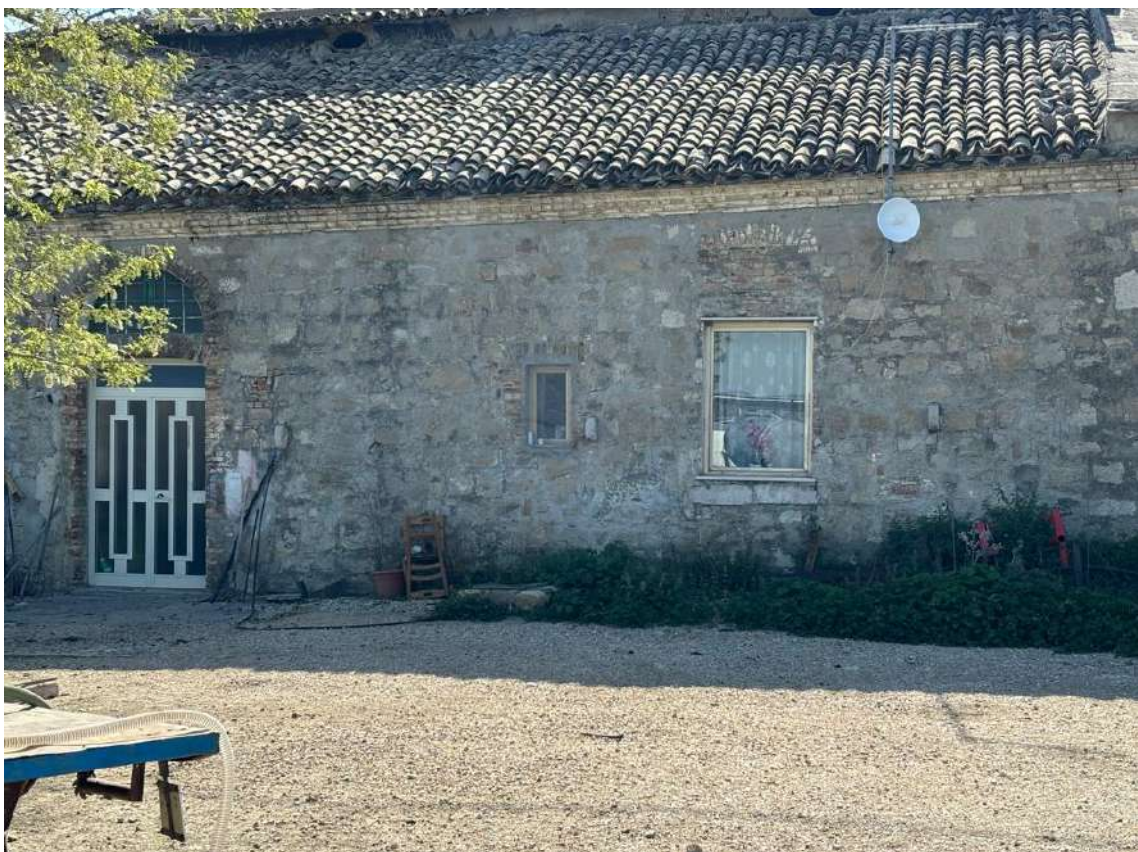
Foto n. 28 – Prospetto posteriore dei fabbricati di cui fgl 22 e porta di accesso posteriore all'immobile fgl 22, p.lla 145 (ex 117)
