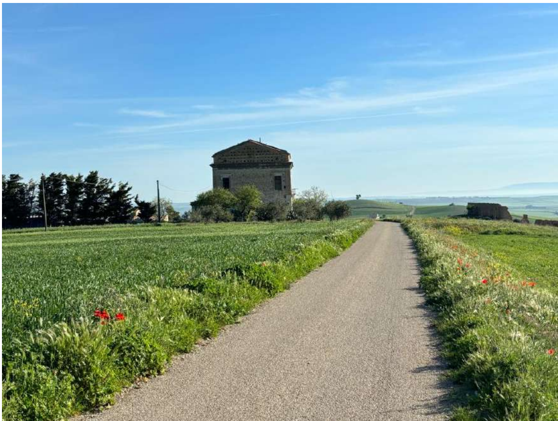
Foto n. 1 – Strada Comunale Crocetta di accesso alle particelle di cui ai fogli 22, 23 e 24
