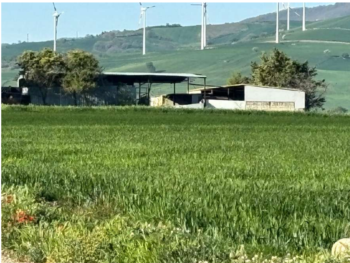
Foto n. 14 – Foglio 22, p.lla 146 (ex 136) con vista sul fabbricato fgl 22, p.lla 138 sub 1
