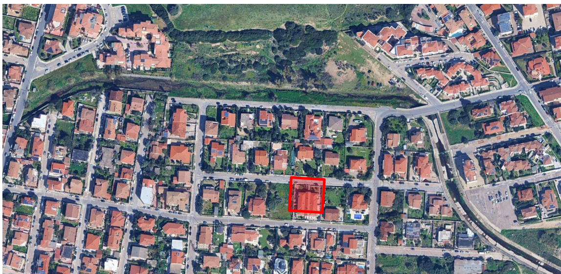
Figura 2 – Ubicazione – il fabbricato oggetto di procedura esecutiva è evidenziata da un perimetro rosso
