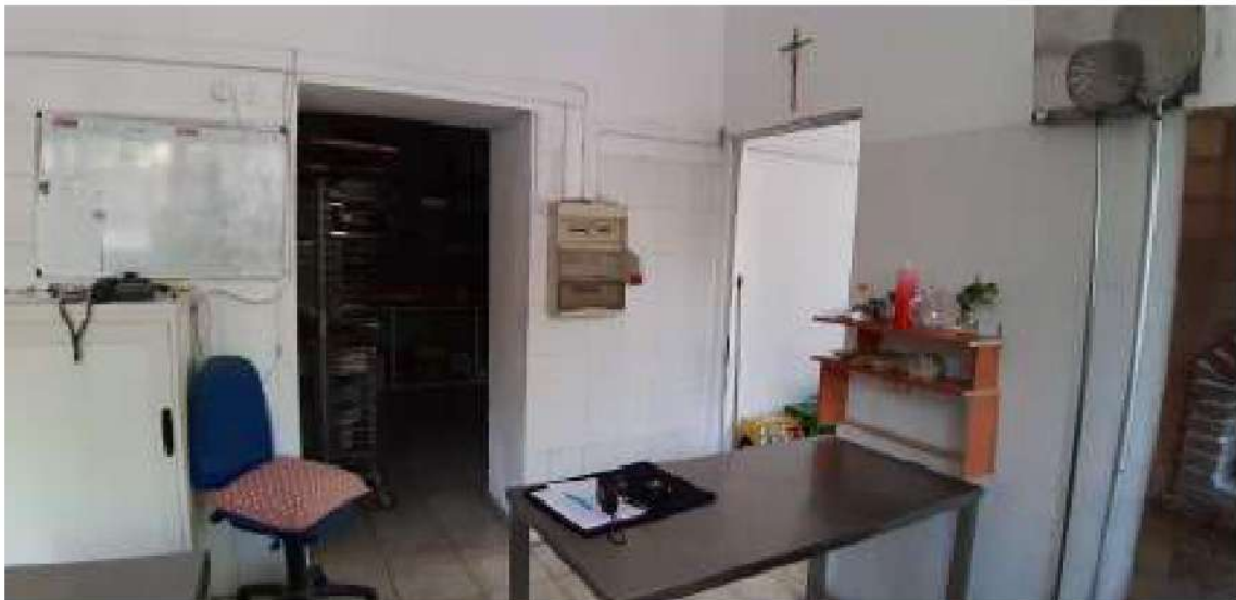
Foto 29: Sala lavorazione e ingresso dispensa 1
