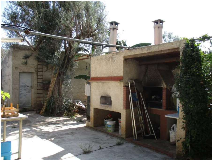
Foto 5: due dei manufatti rilevati sul lotto di terreno 1485 non indicati in catasto
